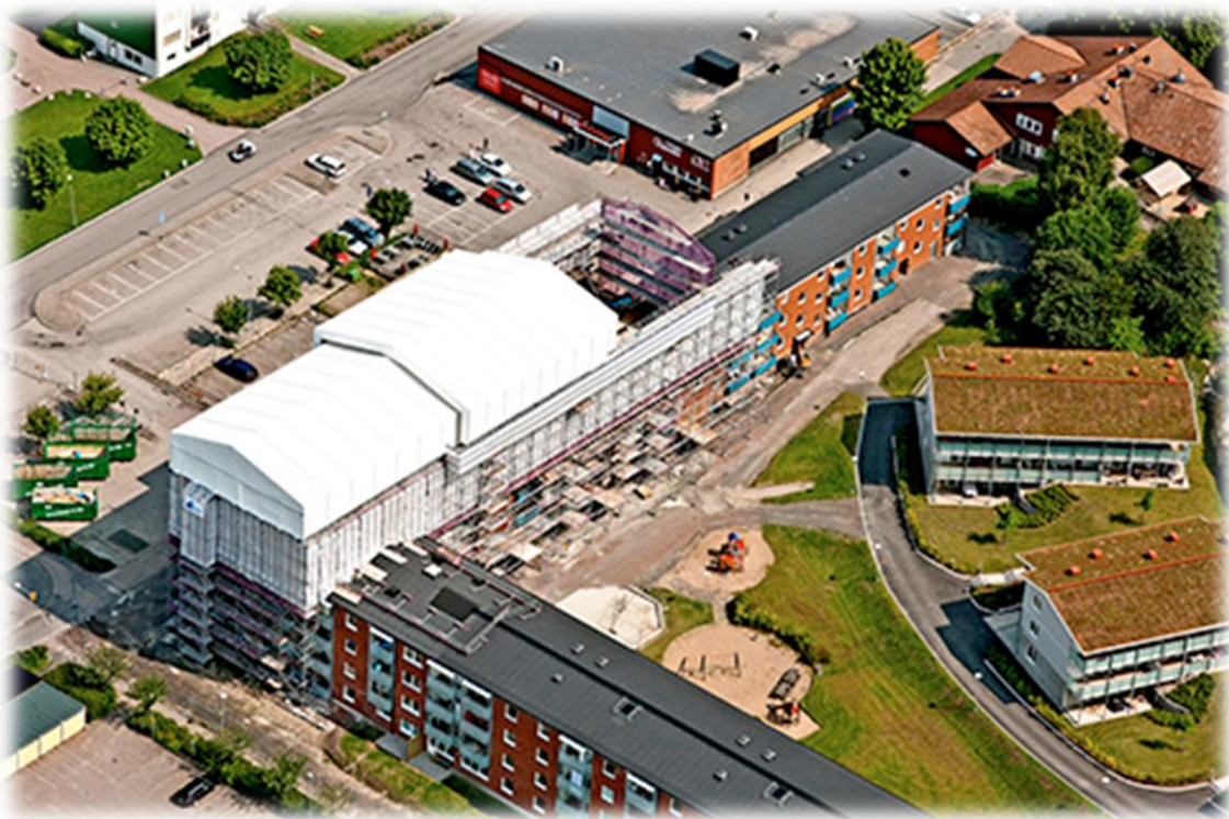
Flygbild: Kvarteret Apelsinen, om- och påbyggnad Foto: Bergslagsbild
