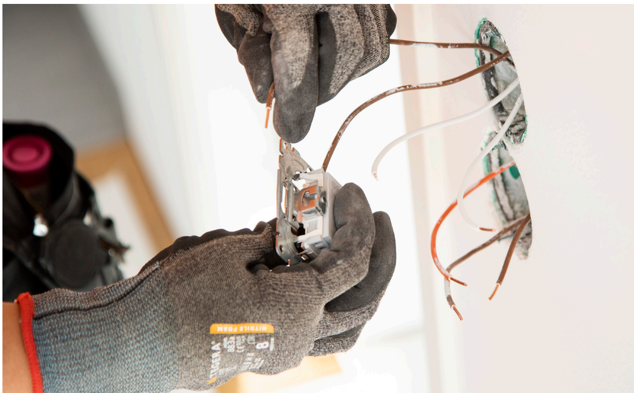
Den uppdaterade standarden SS 4370102 förtydligar bland annat placering av el- och kommunikationsuttag. Foto: Tobias Sterner
