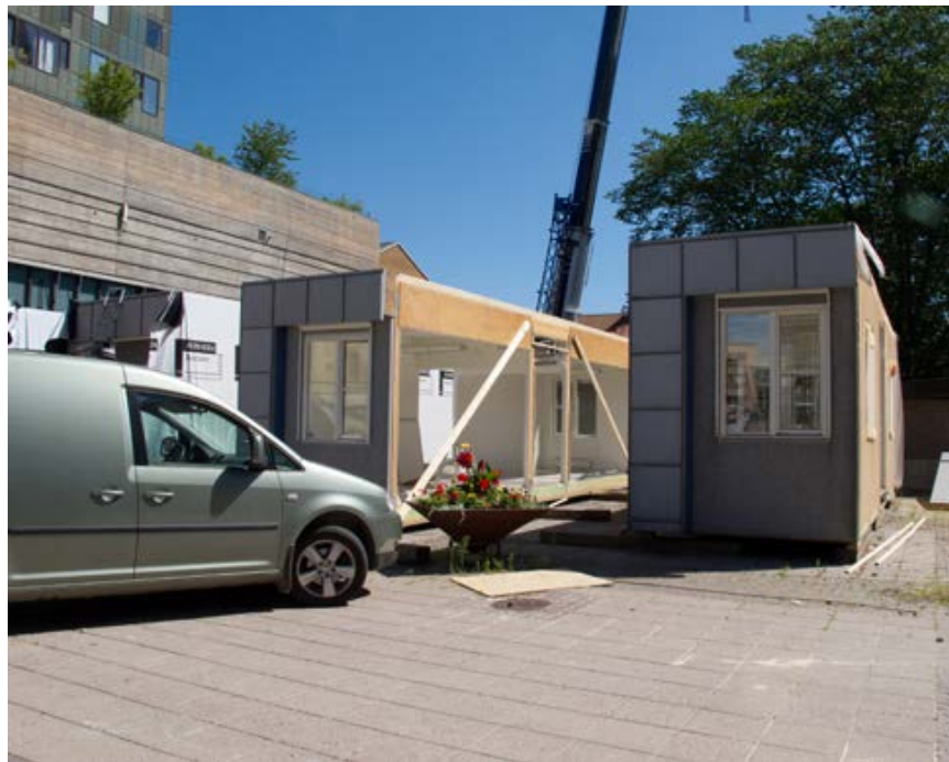
Modulbyggnad under flyttning.
