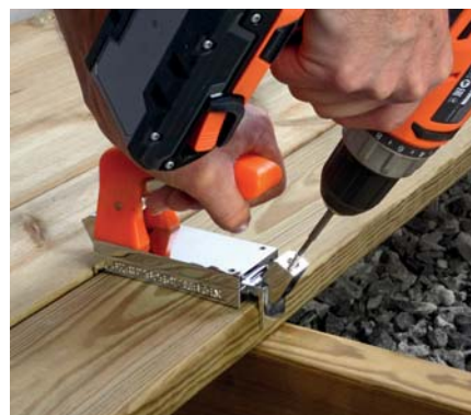
3 Montera Börja med den yttersta skruven.
