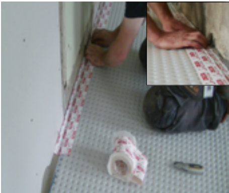
29. Applicera DELTA®-MULTIBAND runt om White Line fuktskyddsmattan. OBS! Vik ner tejen längs kanten utan att trycka ner mattkanten.
