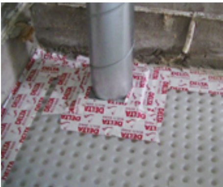
35. Montera ventilationsröret på sugpunkten.
