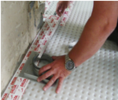
30. Mät ut vart sugpunkten skall vara enligt ritningen. Markera på White Line fuktskyddsmattan.
