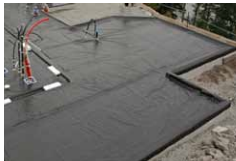
Montage DELTA®-Radonsperre i Norge
