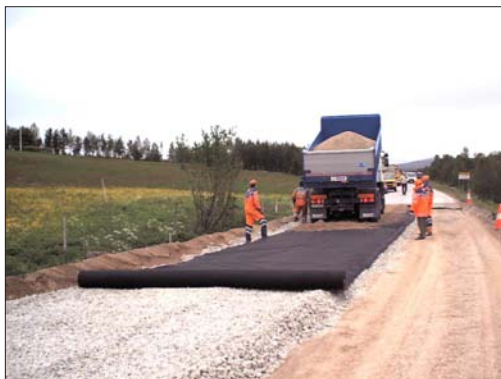
Figur C4-2c. Inkörning av bärlagret.
