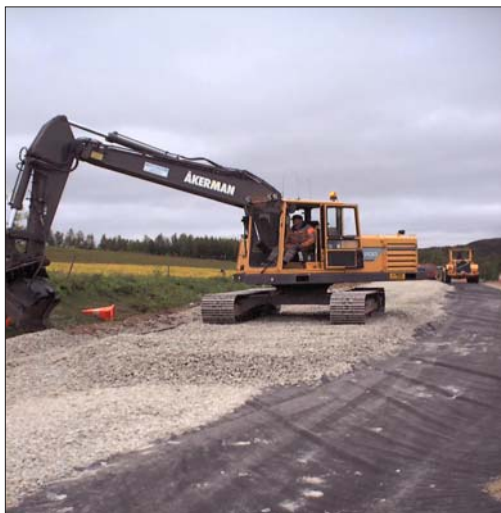
Figur C4-2b. Planering och packning av skumglas.
