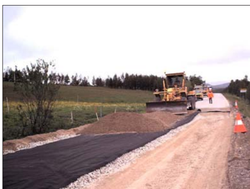
Figur C4-2d. Planering av bärlagret med väghyvel.
