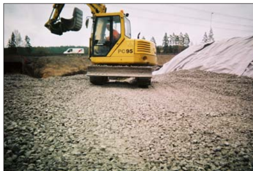
Figur C1-2c. Packning av skum- glaslet med band- tryck 45 kN/m 2 .
