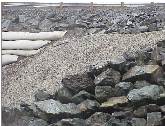
Figur 3.2. Provisorisk vägsträcka med släntlutning 1:1,25 där skumglas och lättklinker använts som lätt fyllning. Observera att lättklinkern har armerats med omlottladga geotextiler för att klara den branta slänten medan skumglasslänten ligger utan åtgärder.
