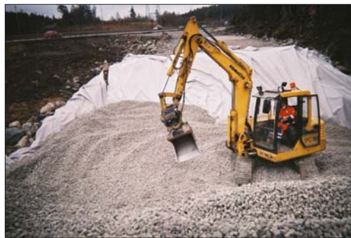
Figur C1-2b. Planering och packning av skumglaslet med grävmaskin.
