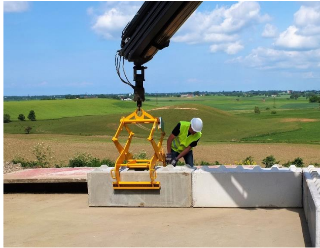
Figur 6.4a-b. Blockhantering med hjälp av universalhuvud samt mekaniskt klämyftdon.
