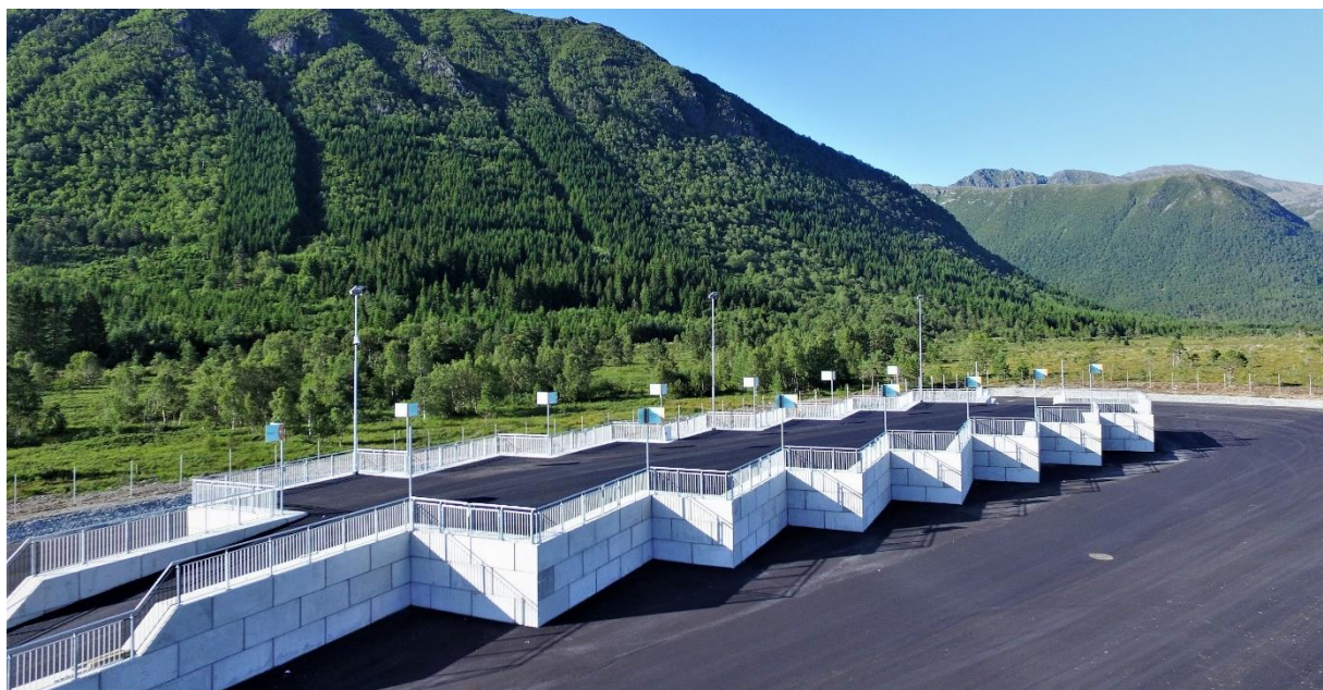
Figur 1a. Avfallsstation utförd med C3C Blocksystem®.
