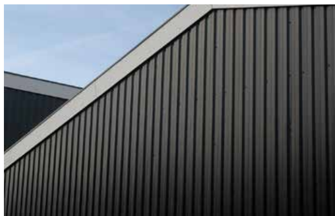
Plannja 19. En snabbmonterad fasadprofil som kräver minimalt med underhåll.
