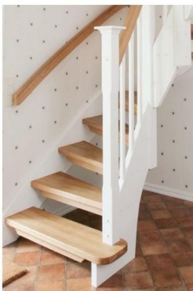
Blocksteg med öppet första steg.
