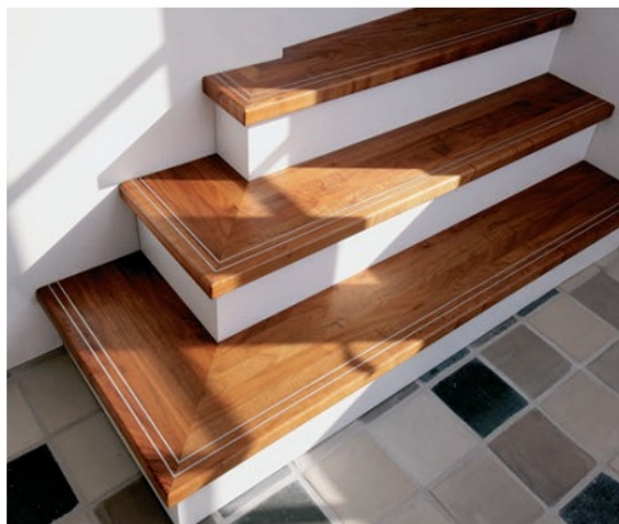
Utvinklad trappstart. På bilden ses även steg med infrästa halkskydd / kontrastmarkeringar av metall.
