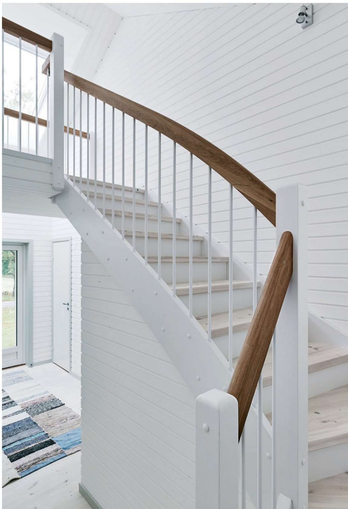
Tät L-trappan Design Tradition med plansteg i vitlaserad furu, vanger och sättsteg vitmålade, handledare nr 1 i oljad ek med ståndare Steel 14 white och vitmålade ändstolpar typ 1 med topp R. Första insteget som ett integrerat vilplan.
