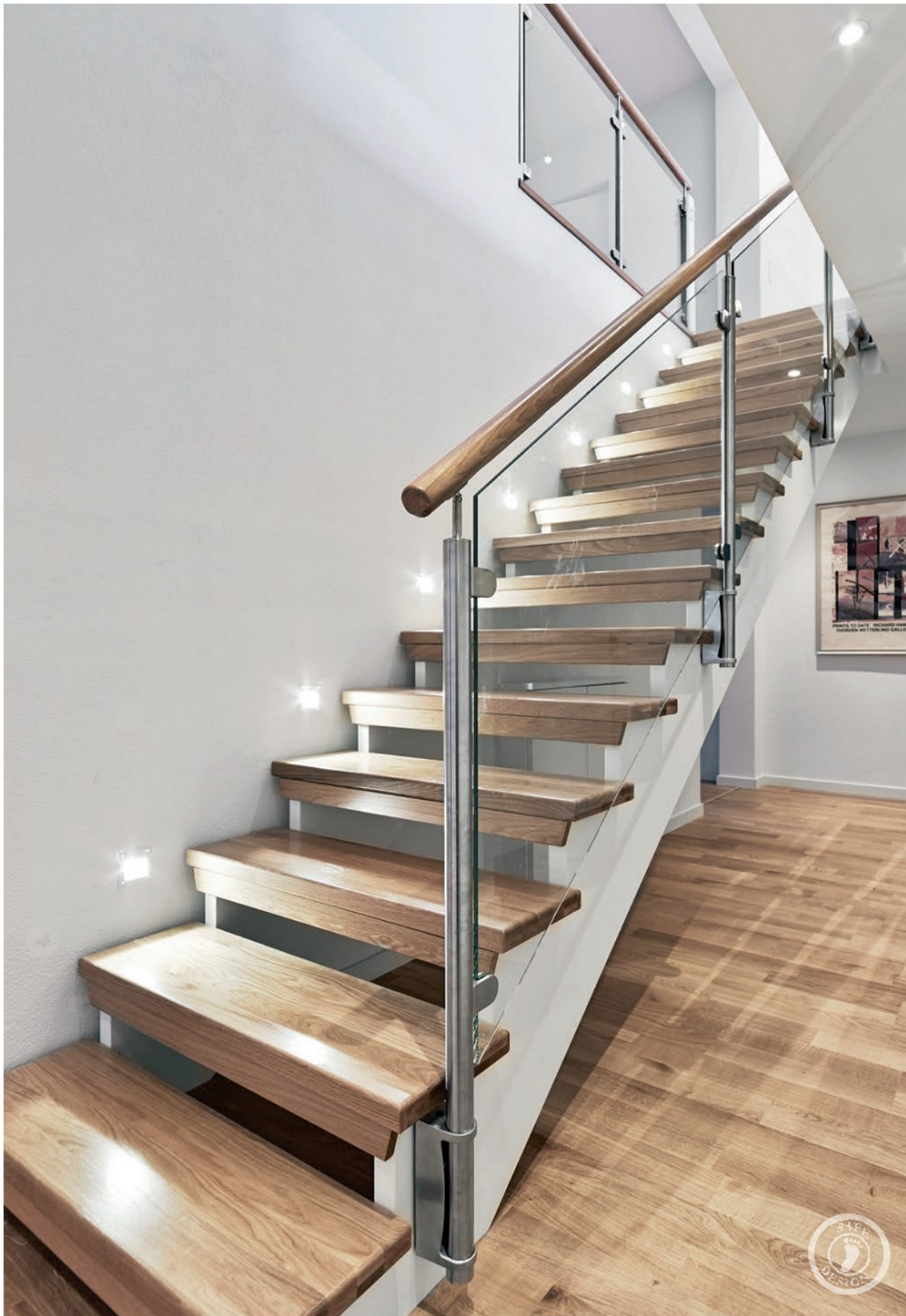
Rak öppen trappa Design Ovanpåliggande, plansteg i lackad ek helstav, vita vanger, ekhandledare, sidomonterade stålstolpar och skydd av laminerat glas. Vägglampor placerade efter trappritning.
