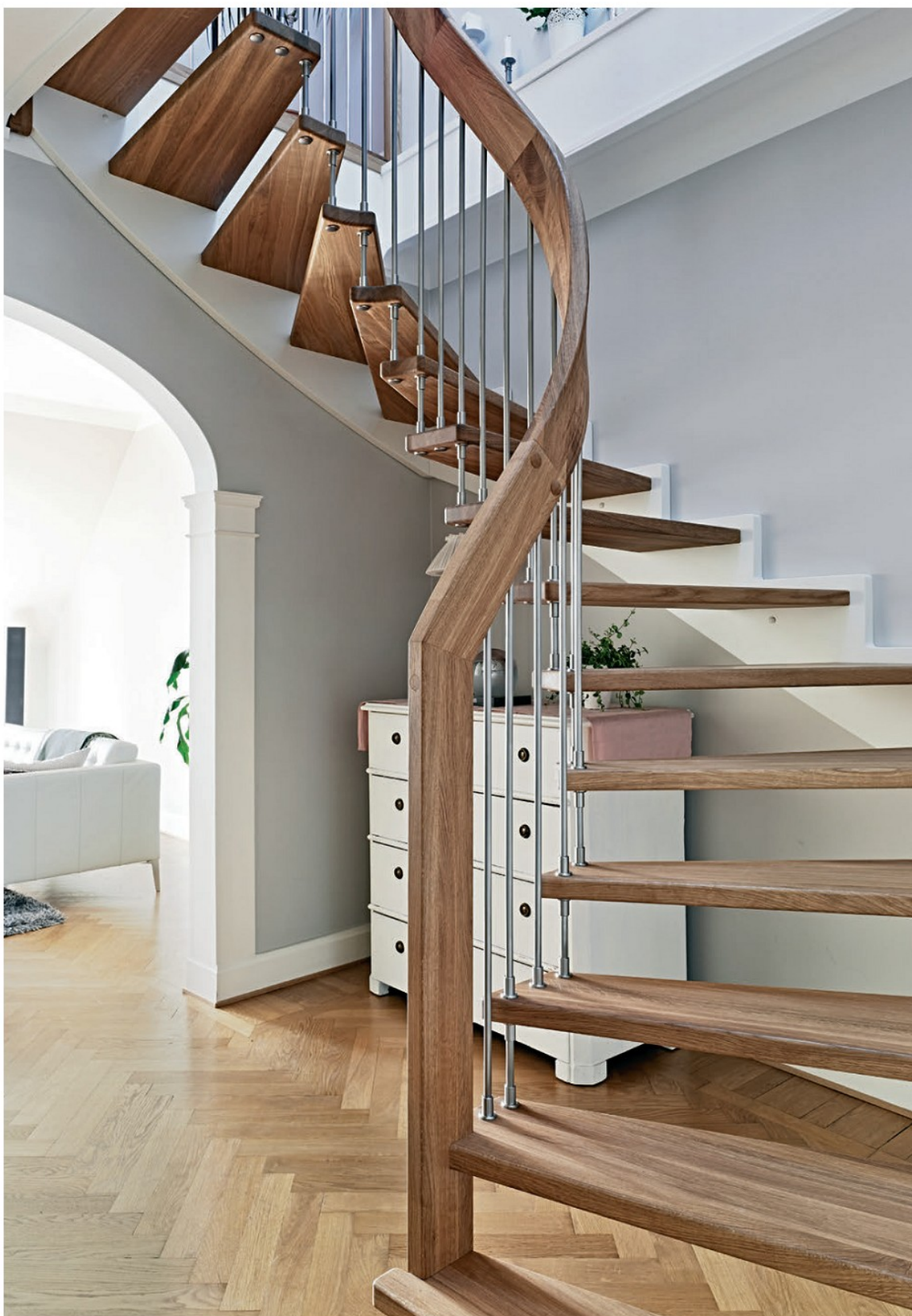
U-trappa Design WF, plansteg i oljad ek, ståndare steel 14 mattborstad, handledare och stolpe typ WF med Soft topp. Helsvängd handledare med mjukt avrundade hörn s.k. krymmlingsböjar", vita NewAge vanger. Notera: Safe Design uppfylls om trappan kompletteras med barnskyddslist under steget.
