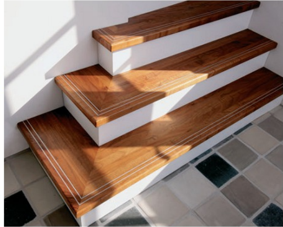
Utvinklad trappstart. På bilden ses även steg med infrästa halkskydd / kontrastmarkeringar av metall.
