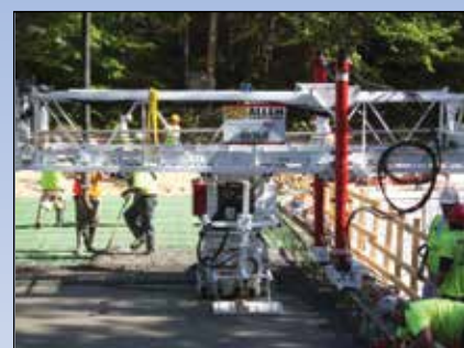
Hydrauliska ändstöd (Tillval på 4836B och 6036B, standard på 6048B)
