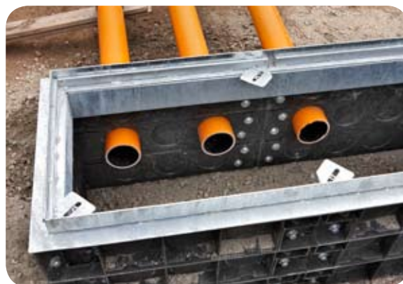
Istället för att borra slås hål i standarddimension (110 mm) ut i kabelbrunnen. Lösningen kallas knock out-hål.
