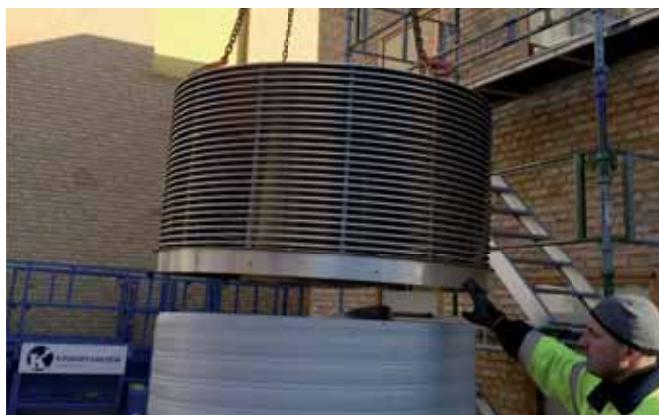
Koppla huvn i lyftöglorna och lyft den på plats.
