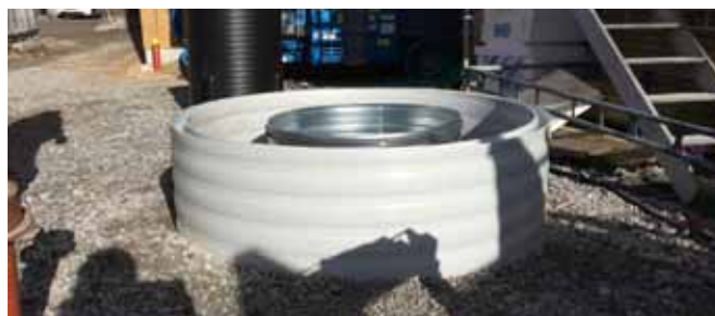
Var noga när du monterar kombihuvn att avluftsroret i tornet ansluts mot kombihuvnens avluftskanal som sitter mitt i huvn.
