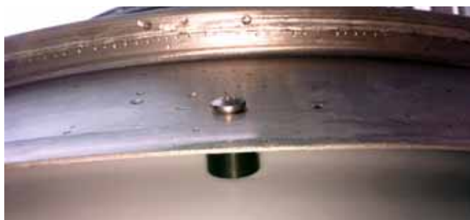
Använd distanserna som följer med likt bild. Distanserna används för att centrera huvn på tornet.
