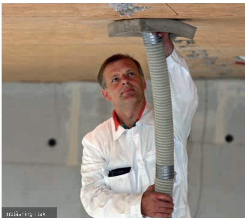
Isolering av krypvind
