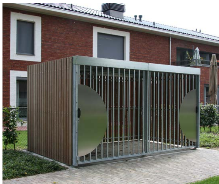
Sido- och bakväggar klädda i hardwood. Framsida försedd med två skjutdörrar av stånggaller.
