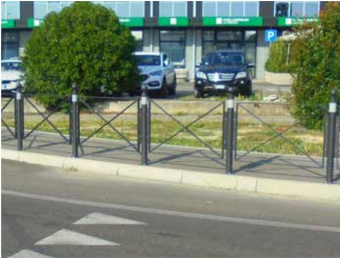
Barriera realizzata da due sostegni in tubolare di acciaio con sovrastante borchia e sfera. Può essere fornita da inghisare o da tassellare al suolo. Pannello realizzato da un telaio perimetrale in tubolare quadro e crociera in piatto con nodo centrale costituito da un anello tondo. La barriera può essere modulare o singola. Le parti metalliche sono zincate e verniciate.
