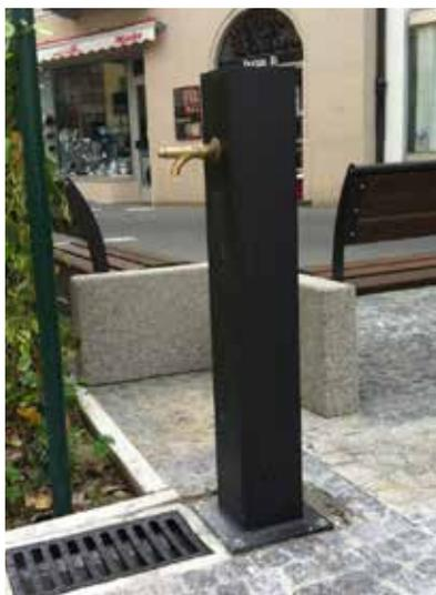
Fontana costituita da una struttura in tubolare d'acciaio quadro chiusa nella parte superiore da un tappo in acciaio. Alla base è saldata una piastra quadrata predisposta con fori per il fissaggio tramite tasselli. Tutte le parti metalliche sono zincate e verniciate. Il rubinetto in ottone nichelato è del tipo a pulsante frontale con molla di ritorno. La caditoia è interamente in ghisa verniciata.
