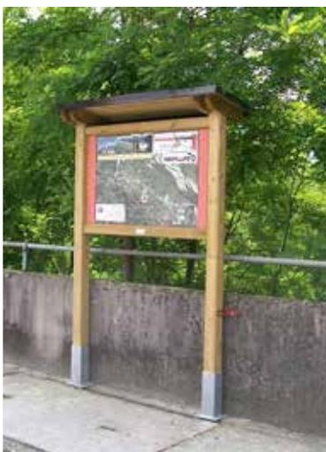
Bacheca con copertura ad una falda. È costituita da 2 montanti e due traversi orizzontali con quali quadri in legno di pino nordico. Il pannello è realizzato con perline.
