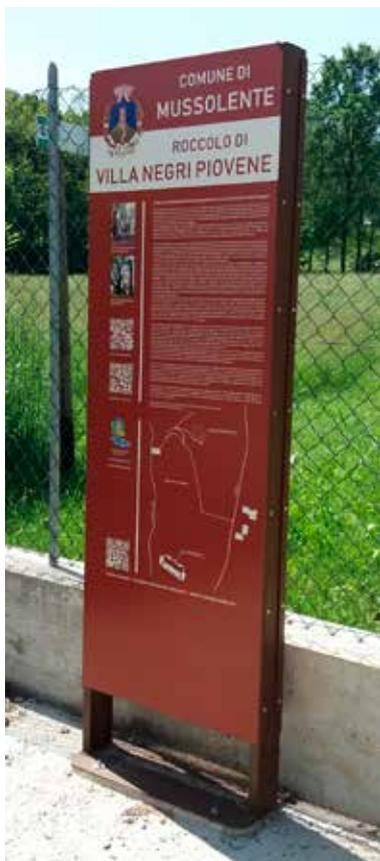
Totem bifacciale composto da un telaio e da due pannelli espositivi. Il telaio è realizzato in tubo rettangolare con alla base una piastra tagliata a tecnologia laser con la predisposizione di fori per il tassellamento al suolo del totem. I pannelli espositivi sono realizzati in lamiera opportunamente piegati e successivamente fissati con viti nella parte laterale e all'estremità superiore e inferiore del telaio. Tutti i componenti sono zincati e verniciati. La viteria è in acciaio inox.
