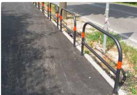
Barriera realizzata mediante piegatura a freddo di tubolare in acciaio D.48 o D.60 a forma di U rovesciato, con o senza traverso di collegamento saldato tra i montanti. La barriera può essere fornita da inghisare, da tassellare o amovibile. Può essere fornita zincata a caldo, solo verniciata o zincata e verniciata.
