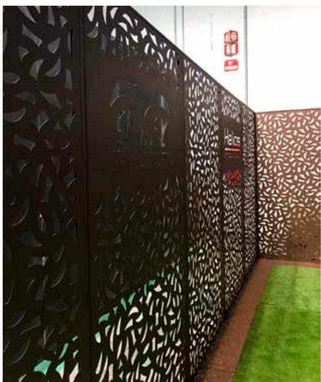
Pannello realizzato da due sostegni in tubolare. Può essere fornita da inghisare o da tassellare al suolo. Pannello realizzato da un telaio perimetrale in tubolare quadro e lamiera tagliata al laser. Il pannello può essere modulare o singolo. Le parti metalliche sono zincate e verniciate. È possibile realizzare un design diverso della lamiera con forme a piacere.
