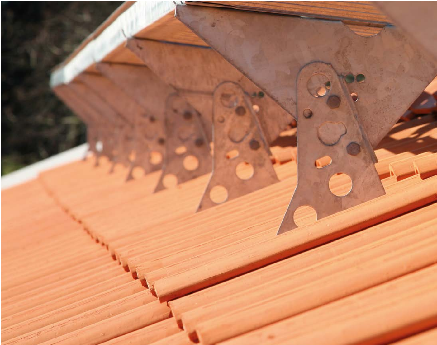
Konsol med bryggfäste på lertegeltak.
