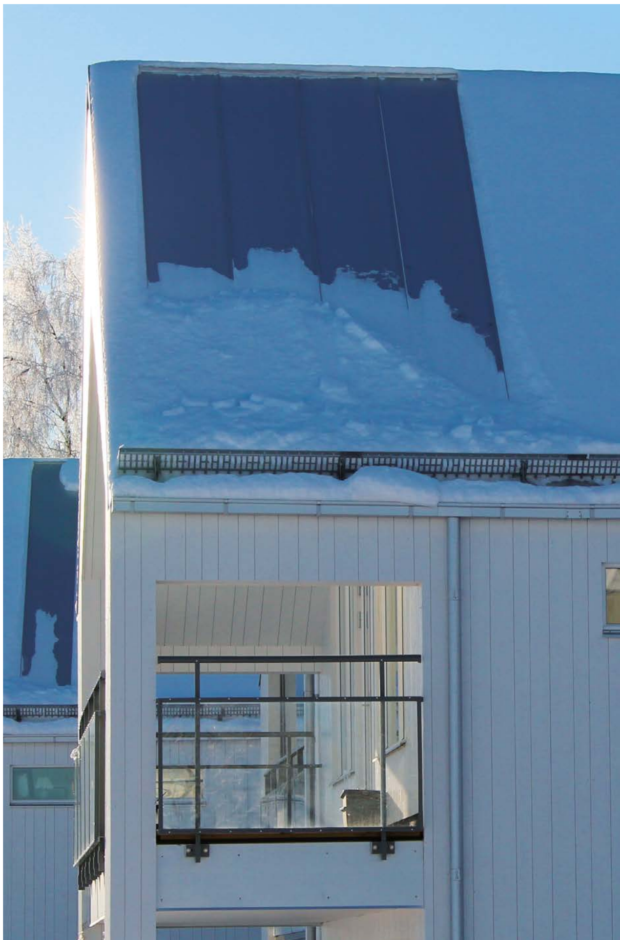
Snörasskydd i profildurk med israstapp till bandtäckta tak.
