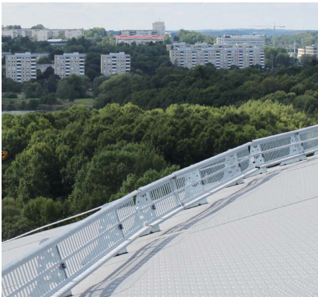
Snörasskydd monterat på slät tätplåt.
