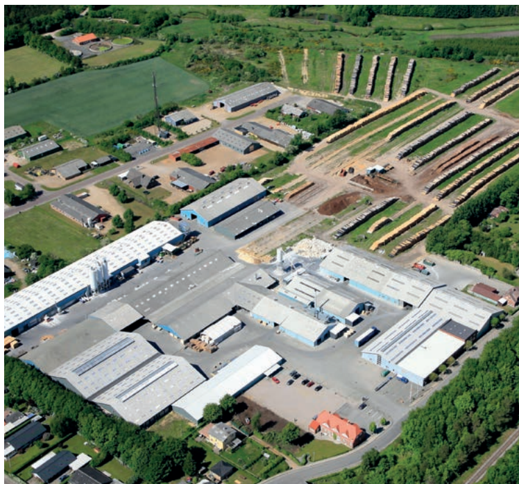
Troldtekts fabrik i Trolldhede.
