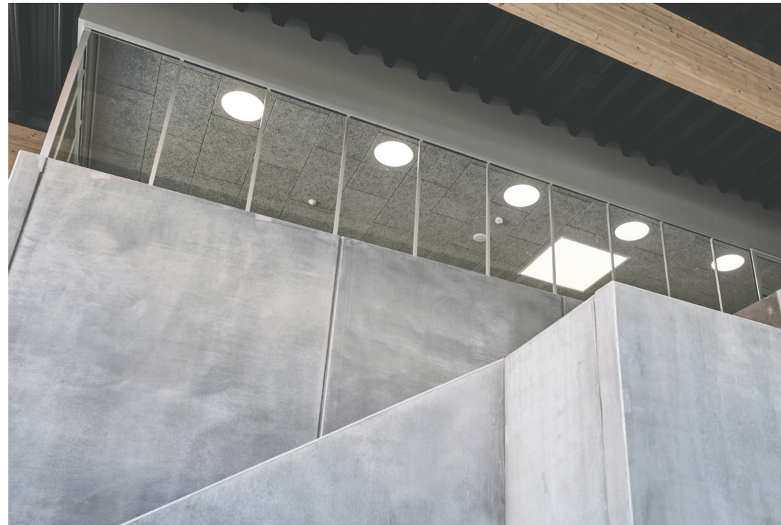
Glass Front | Fire EI 60. Skarvar med spröjs
