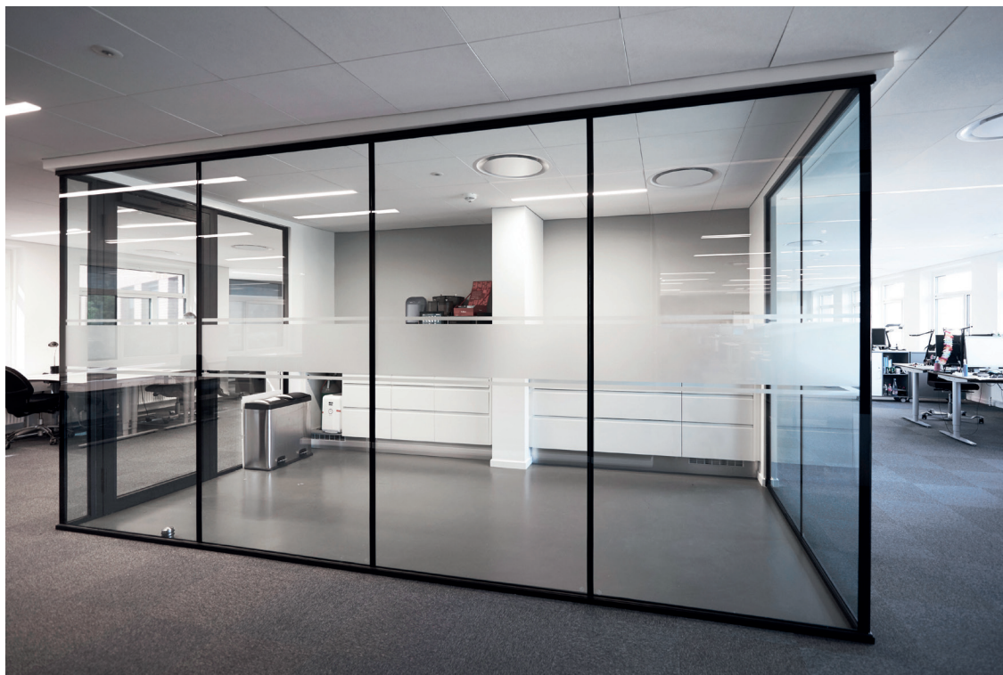
Glass Front | Fire EI 60. Fogade skarvar och stålramsglasdörr i fullhöjd
