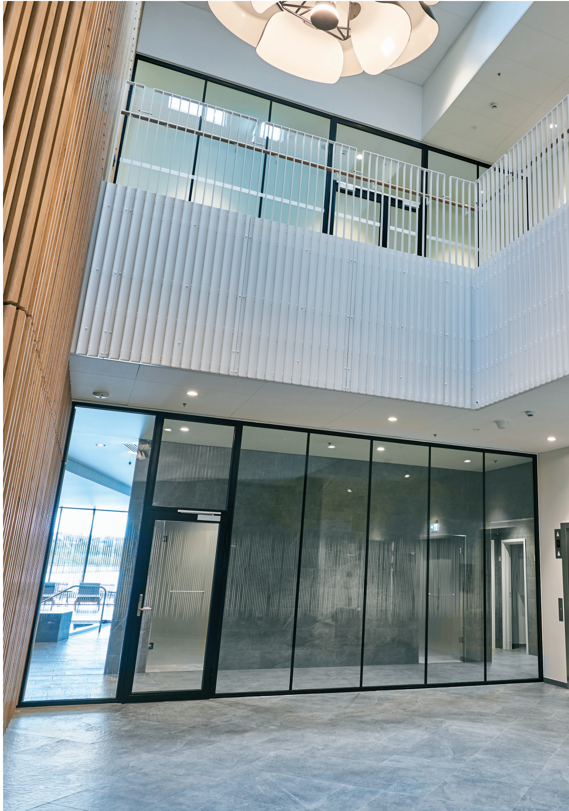
Glass Front | Fire EI 60. Fogade skarvar och stålramsglasdörr
