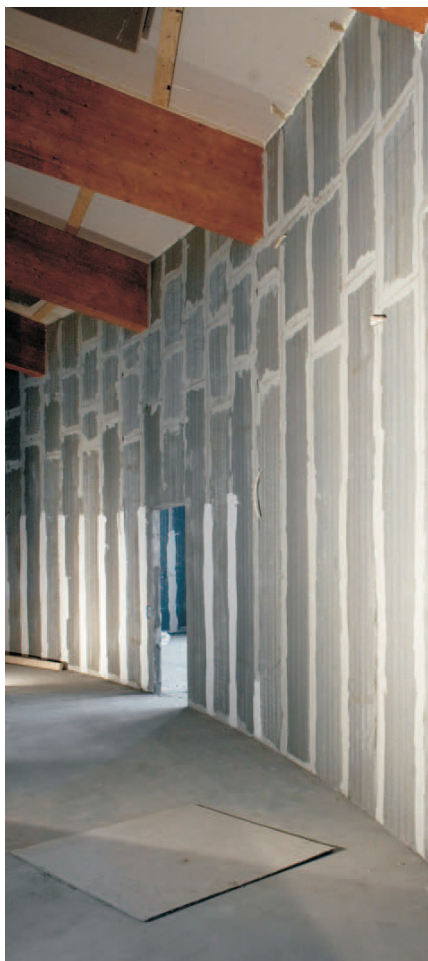
Elementskarvar täckta med fogremсор av papper.
