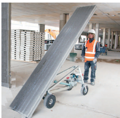
Med AKO-lyftare är det enkelt att flytta och resa elementen.
