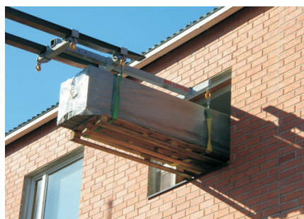
I renoveringsobjekt lyfter man behändigt i elementen genom ett fönster med telesopkran.
