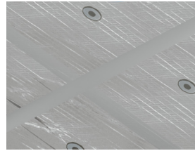
Industry AL system med skruv och bricka
