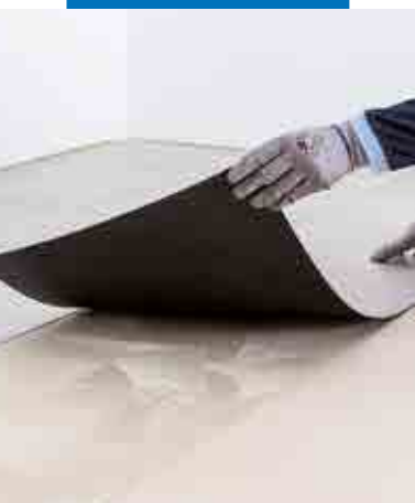
Limning av LVT-plattor med Ultrabond Eco 4 LVT
