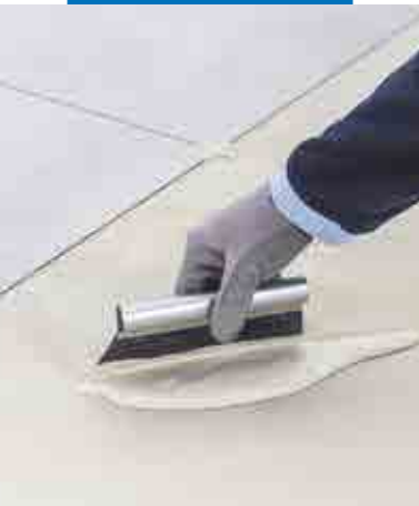
Applicering av Ultrabond Eco 4 LVT och limning av LVT-plattor med breda fogar och distanser
