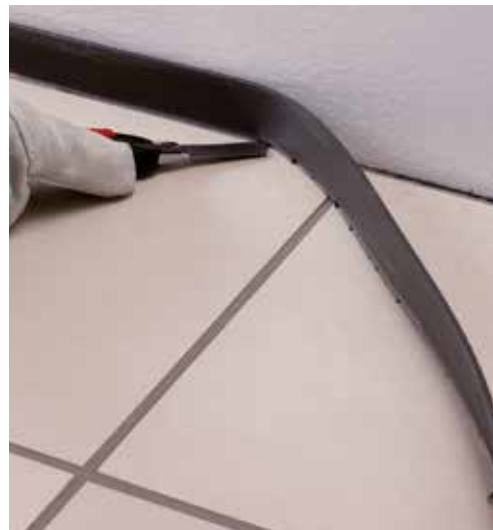
När fogbruket har härdat skärs överskott av Mapesonic Strip bort runt kanterna .
