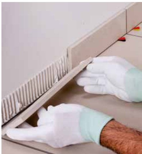
Sätt sockel runt rummet utan att låta den komma i direkt kontakt med golvytan.
