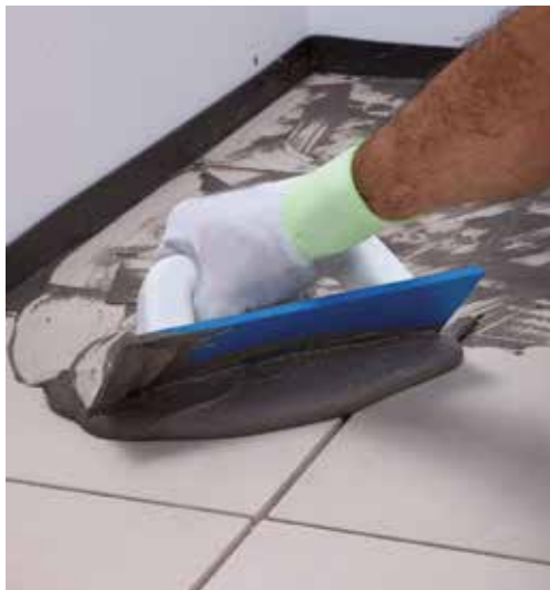
Applicera fogmassa på golvytan.
