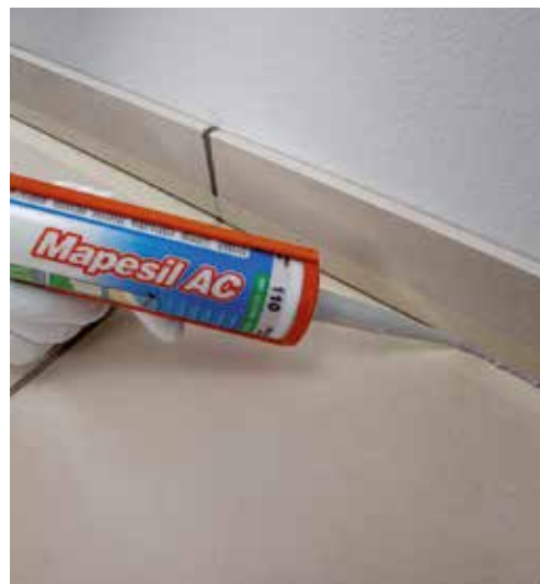
Täta spalten mellan sockel och golv med lämpligt flexibelt tätmedel ur Mapeis produktprogram.
