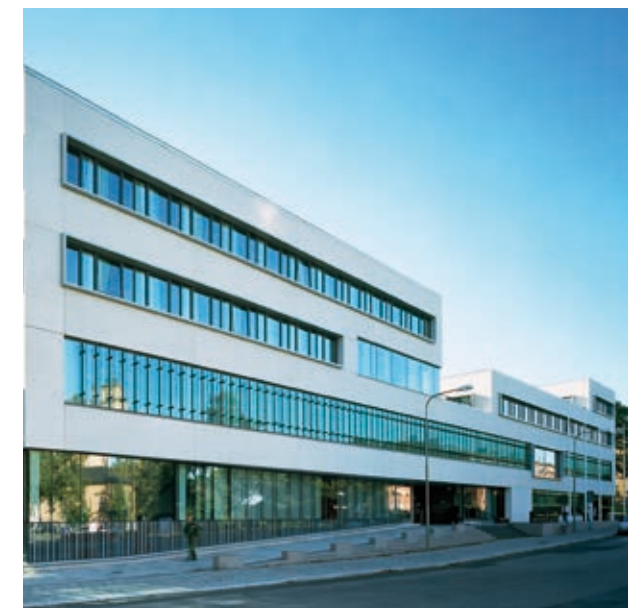
Bröstningselement av sandwichtyp.
