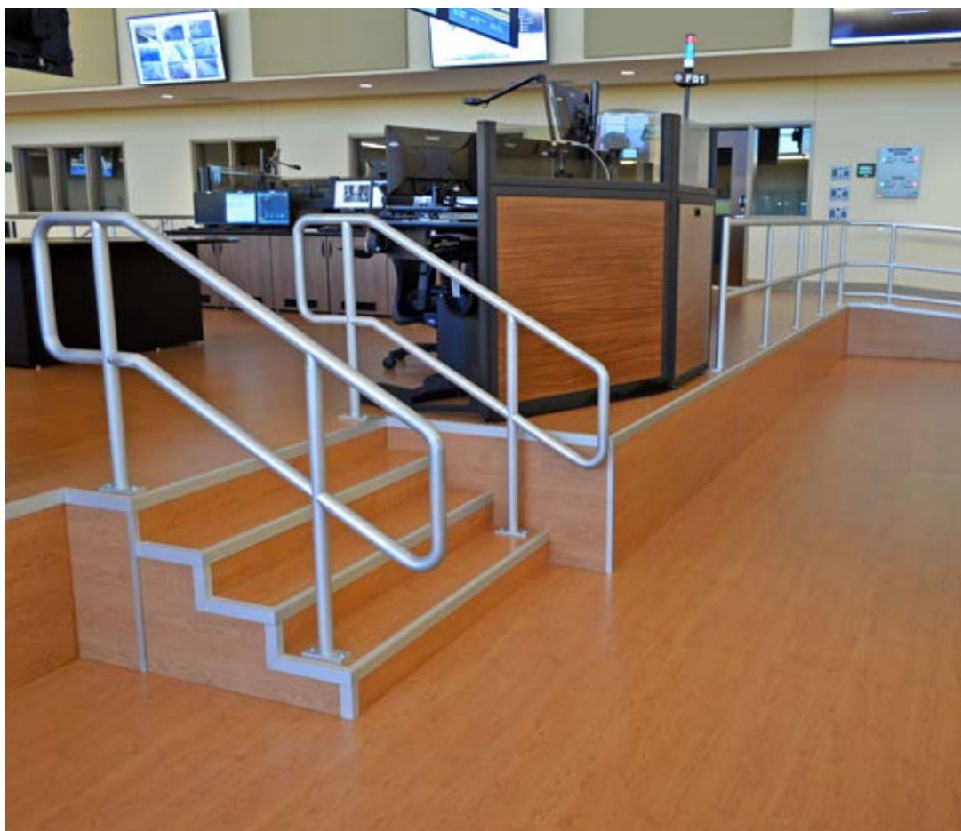
Golvplattor, trappor, vertikaler och ramper på Harford County Emergency Communications Center i USA är tillverkade med vår A0040 Ek.
