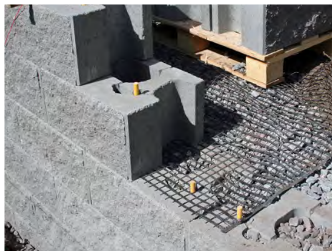
Keystone Compac med geonät.
