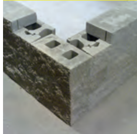
Girning av toppsten i hörn
