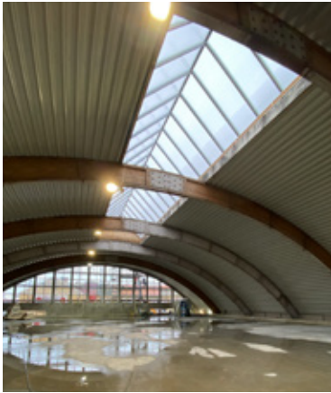
Kvarteret Spårvagnshallarna. Den gamla busshallen på Planteringen i Helsingborg får nytt liv som garage för de boende.
