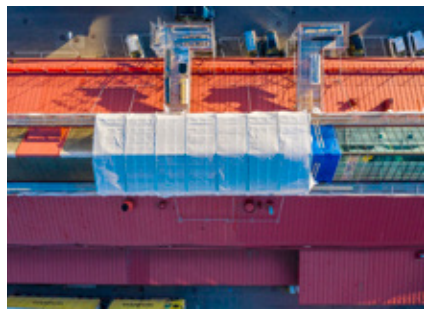
Nytt glastak Till vänster syns den gamla, igensatta, konstruktionen. Till höger det nya glastaket från Scanlight.
