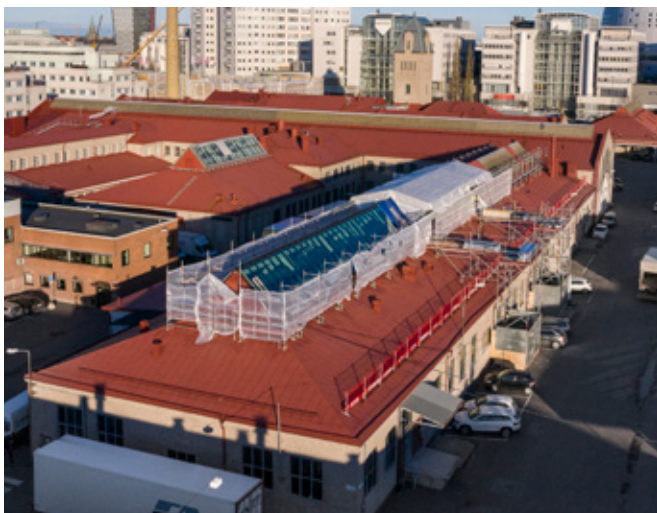
Hus 26, Slakthusområdet Stockholm. Nytt glastak över äldre slakthus som byter skepnad till att vara en del av områdets utveckling till en urban stadsdel.
