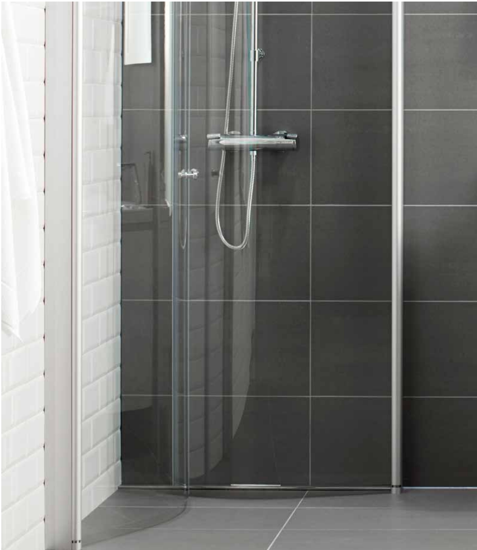
Dusch: Showerama böckade duschdörrar, klart glas och knopphandtag | Spegel: Reflect spegel med LED-belysning, 60 cm Underskåp med tvättställ: Vinta Art 60 cm underskåp i vitt, med Vinta Art tvättställ | Toalett: Vinta Art golvstående toalett
