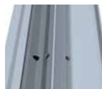
Dränering i rälsprofil
