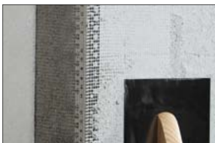
Vid hörn och fönstersmygar monteras Skalflex hörnprofil med nät i grundputs. Vid skarvar skall nätet överlappas med min 50 mm.
