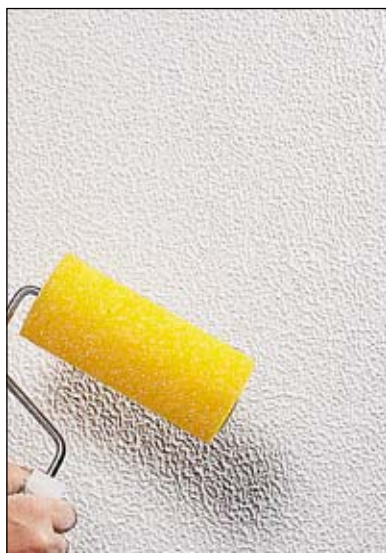
Interiör fin påförd med strukturrulle
