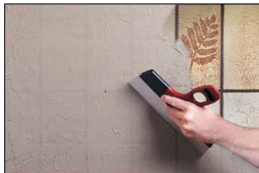
2. En tunn blandning av Multiputs spacklas på plattorna och utjämnas med kalkkvast eller pensel
