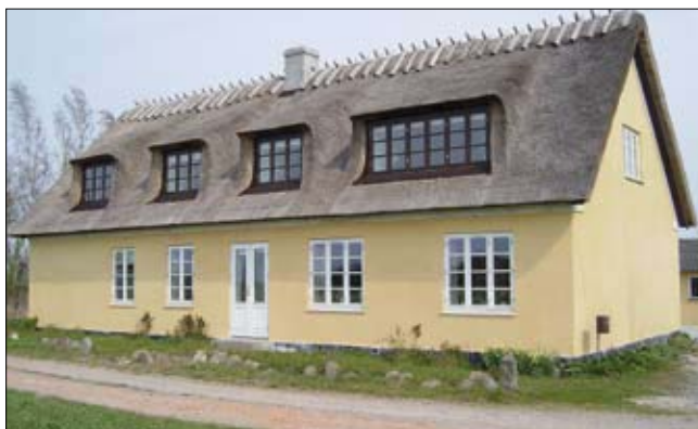
Efter Skaltherm Nätputsrenovering
