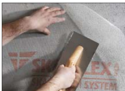
Armeringsnätet trycks in i den våta grundputsen och jämnas ut med t ex putsbräde.
