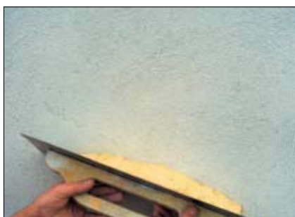
Efter att ytan fått torka 2 dygn påföres ytputsen med Skalcem S2000/CF2000 med en tjocklek av ca 2 mm. Ytan filtas med en torr filtsvamp eller liknande. (OBS! 2 liter av blandningsvattnet ersätts med Beto-Binder)
