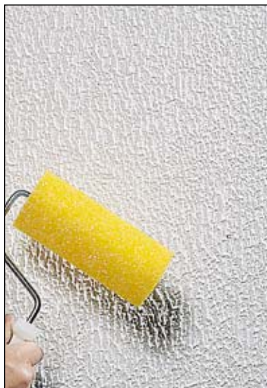
Interiör grov påförd med strukturrulle
