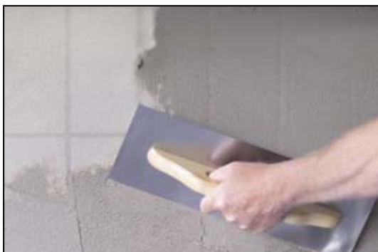
3. Ett jämt lager med Multiputs dras på med en stålskånska
