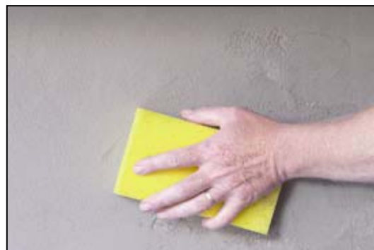
4. Efter några minuter filtas ytan med en lätt fuktad svamp
