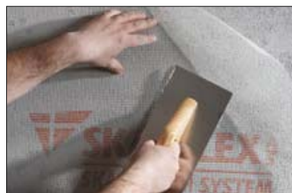
Skaltherm Armeringsnät trycks in i det våta bruket. Nätet skall vara täckt av bruk.
