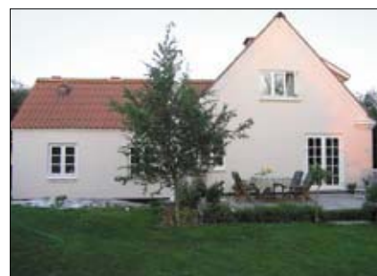
Färdig byggnad med Skaltherm Isoleringssystem.
