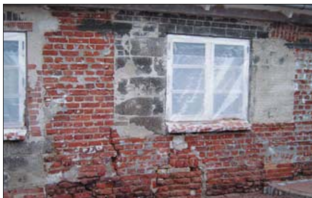
Före Skaltherm Nätputsrenovering
