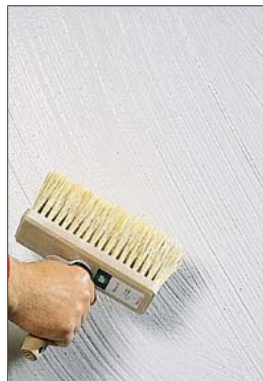
Interiör sand påförd med kalkkvast
