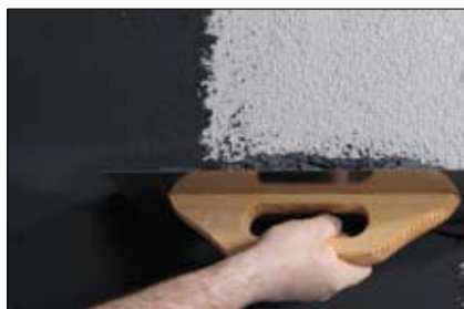
Efter att ytan fått torka 2 dygn påföres ytputsen med Skalcem S2000/CF2000 med en tjocklek av ca 2 mm. Ytan filtas med en torr filtsvamp eller liknande. (OBS! 2 liter av blandningsvattnet ersätts med Beto-Binder)
