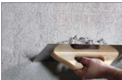
Påför ev. ännu ett lager med Skaltherm grundputs för att täcka nätet. Därefter slätputsas ytan med putsbräde.
