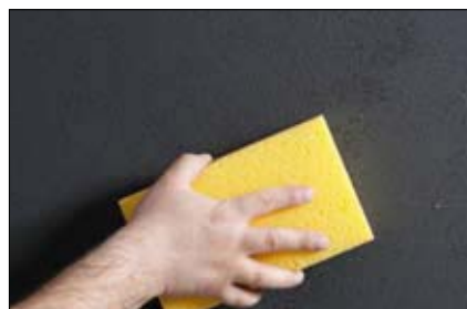
Därefter filtas ytan med svamp eller filtbräde.
