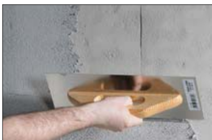
Skaltherm Grundputs påföres efter förvattnning. På starkt sugande underlag grundas först med Skalflex Binder utspädd med 3 delar vatten.
