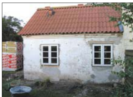
Byggnad för Skaltherm Isoleringssystem.
