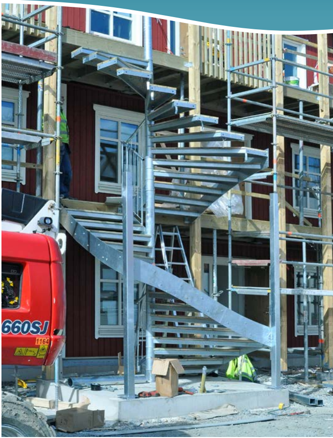
Backa Säteri, Nödinge. En kombitrappa med vangstycken av plattstål och steg av räfflad tryckimpregnerad furu. Trapphuset är helt inklätt med trä. Floby Durk har medverkat hela vägen från projektering till montage.
