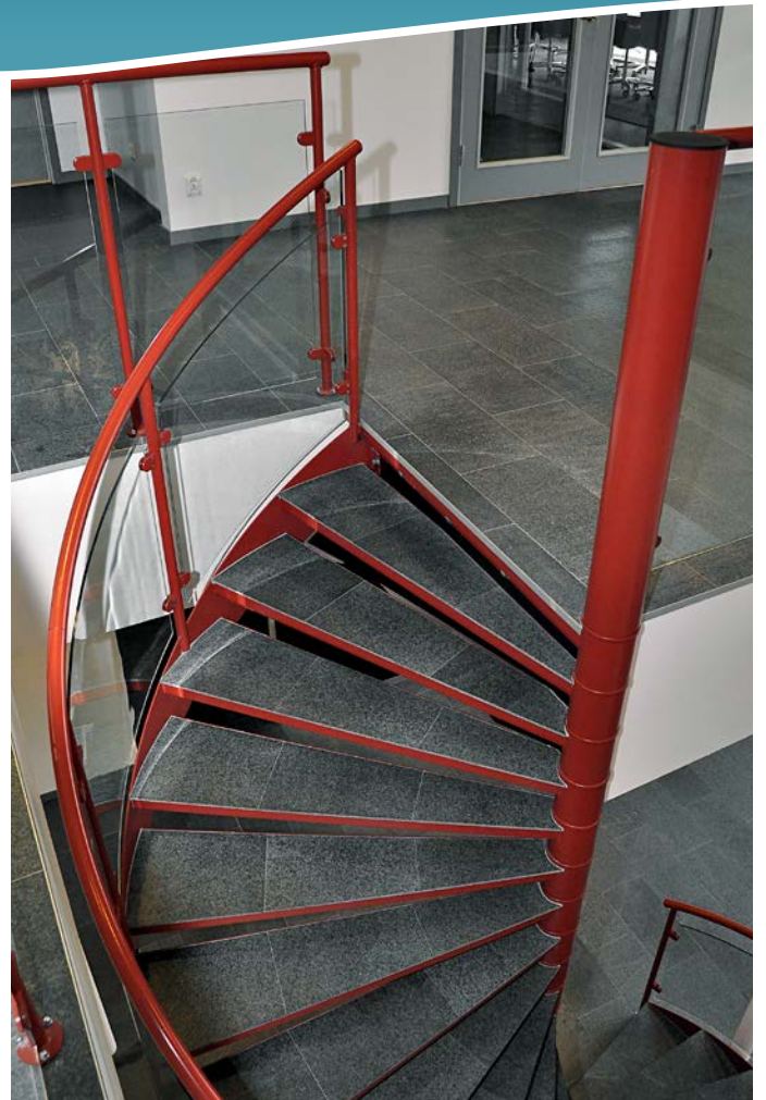
I-Data i Värnamo. Spiralltrappa med vangstycke och klinkerbelagda trappsteg. Glasen i räcket är formade efter trappradien.
