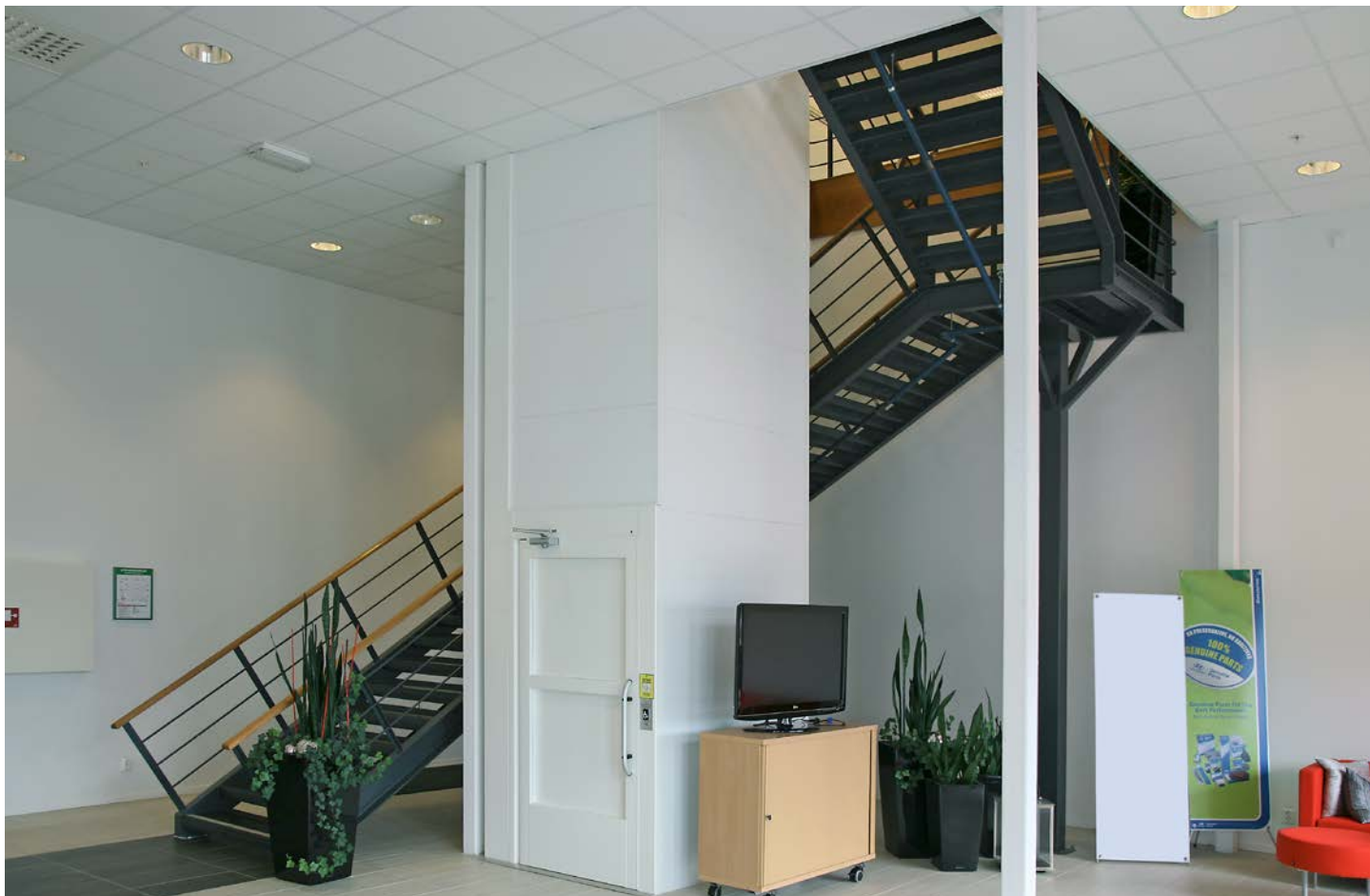
Rak trappa i specialutförande monterad i kontorsdel på logistikcenter. Trappstegen är belagda med klinkers och kontrastmarkeringar på första och sista steget i varje trappplöp. Handledare av ek. Floby Durk har utfört montaget.
