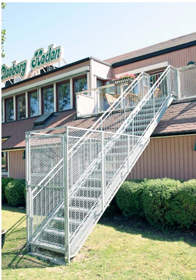
Rak trappa med skyddsbur av sträckmetall.
