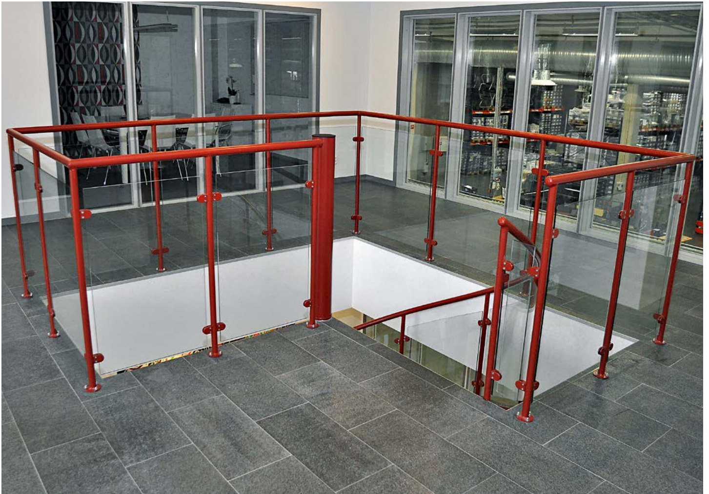
I-Data i Värnamo. Spiralltrappa med vangstycke och klinkerbelagda trappsteg. Glasen i räcket är formade efter trappradien.
