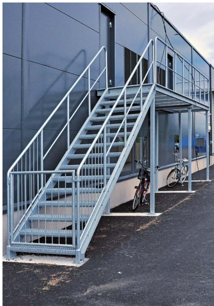
Rak trappa med grind.
