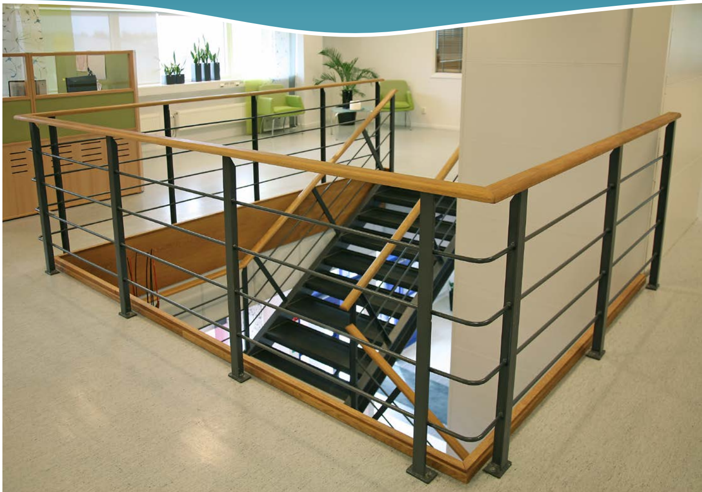
Rak trappa i specialutförande monterad i kontorsdel på logistikcenter. Trappstegen är belagda med klinkers och kontrastmarkeringar på första och sista steget i varje trappplöp. Handledare av ek. Floby Durk har utfört montaget.
