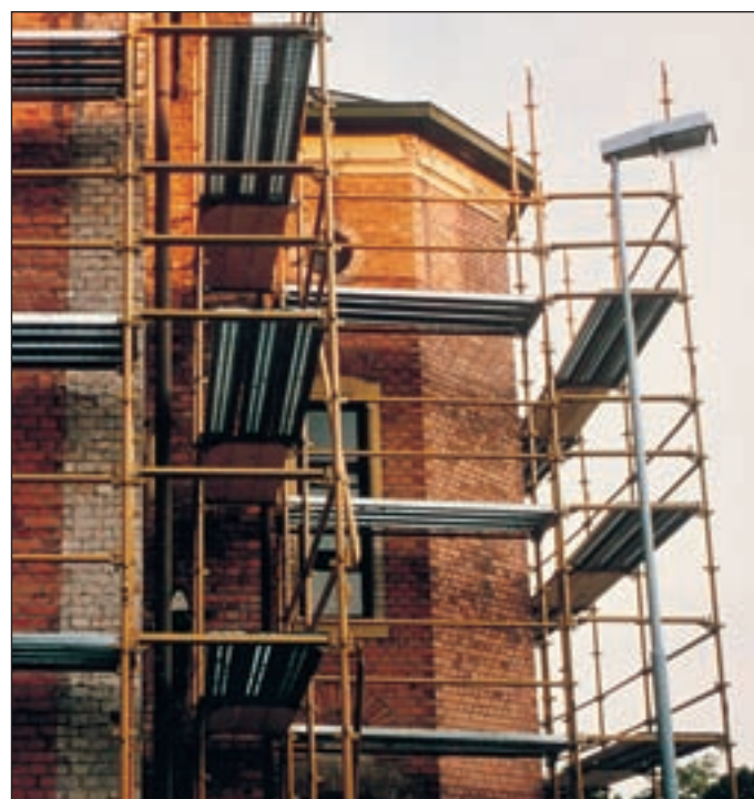
Säkrare byggarbetsplatser med slitsdurk.
