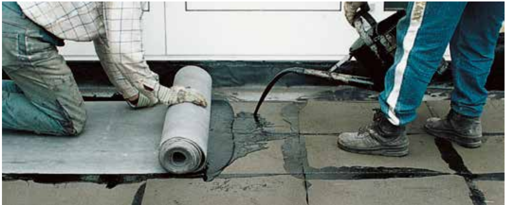
Det första lagret av tätskiktet läggs ovanpå FOAMGLAS® isoleringen.
