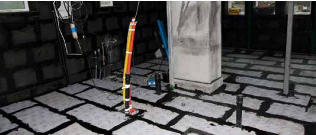
Invändig isolering av golv med FOAMGLAS® FLOOR BOARD.
