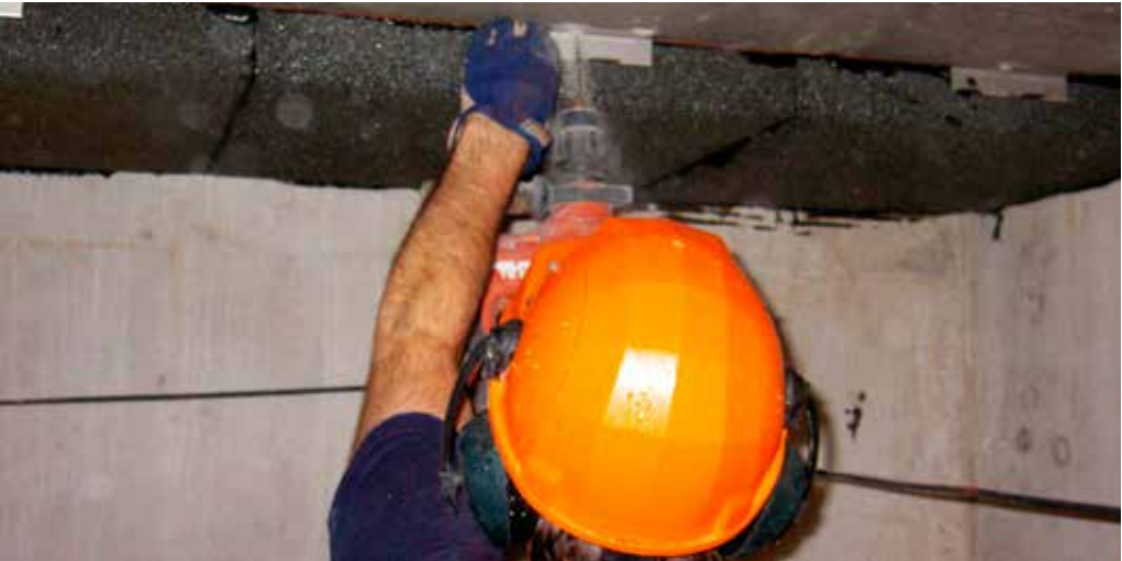
Mekanisk infästning med PC Anker F.
