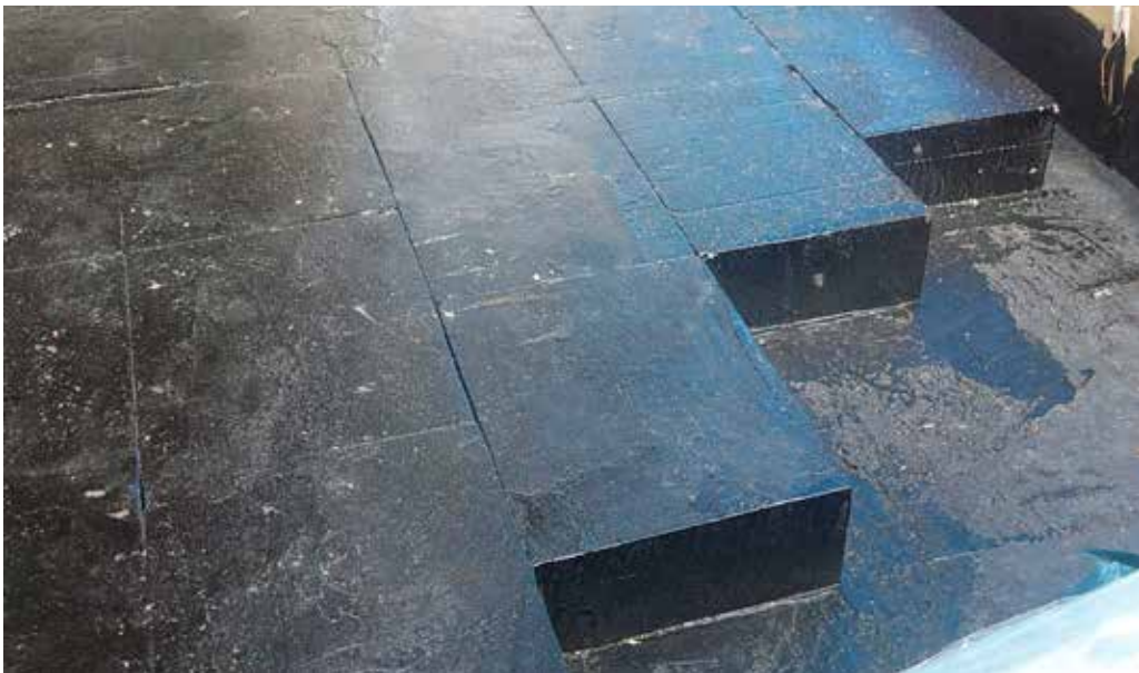
Installerade FOAMGLAS® BLOCK med förskjutna skarvar
