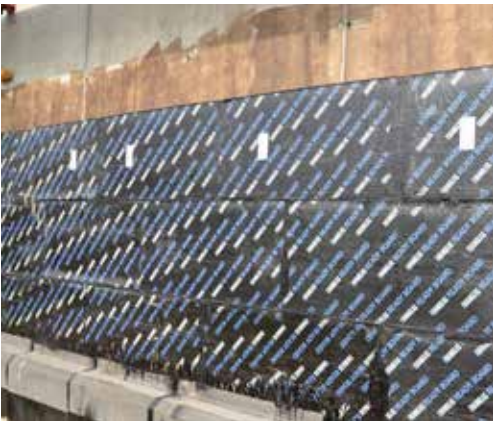
Källaryttervägg med FOAMGLAS® READY BOARD förberett för påsvetsning av tätskikt.
