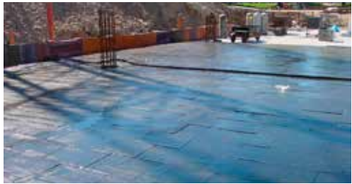
FOAMGLAS® BLOCK lagd i varmasfalt
