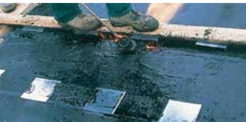
Uppvärmning och nedpressning av taggbrickorna.
