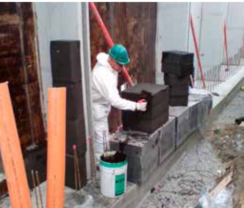
Montering av FOAMGLAS® BLOCK med lim PC56 på källaryttervägg.
