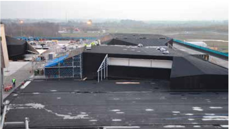
FOAMGLAS® takfallsystem på Emporia i Malmö.
