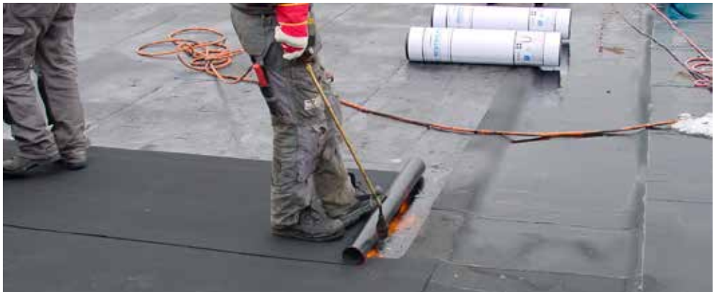
Nästa tätskiktsslag svetsas mot det första lagret.
