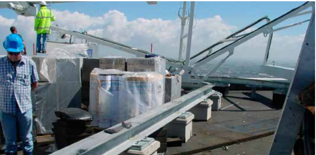
FOAMGLAS® PERINSUL, köldbryggebrytare, under fundament till fönsterhiss.
