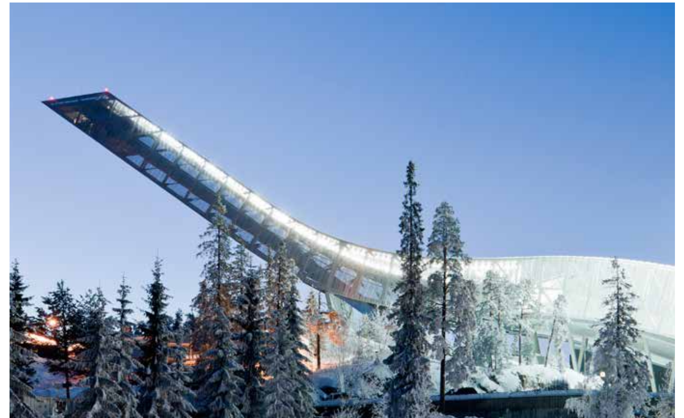
Invändig isolering – Holmenkollen, Norge
