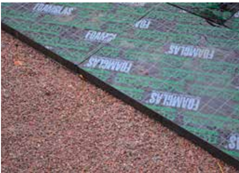
Löst utlagd FOAMGLAS® Floorboard på fingerus.
