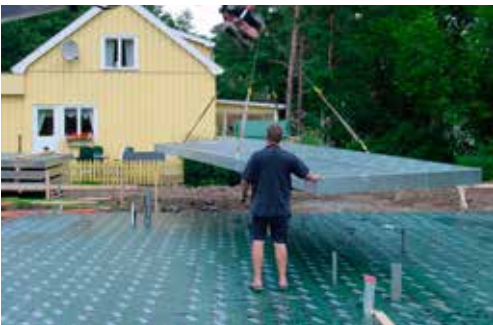
Montage av bottenplatta i Koljern®-tekniken.
