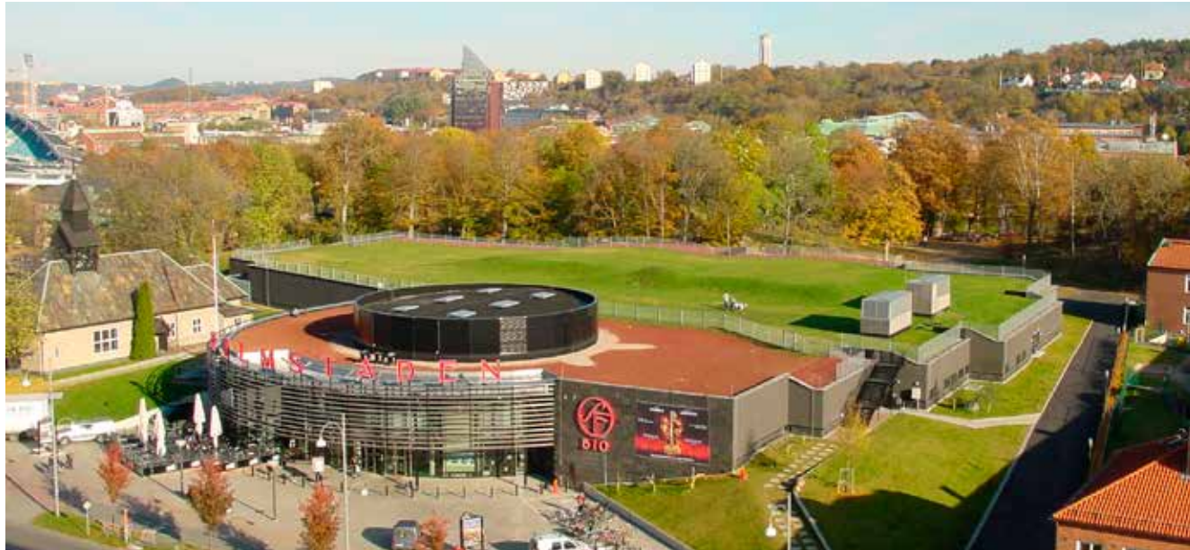
Isolering av grönt tak. Bergakungens Salar, Göteborg, Sverige.
