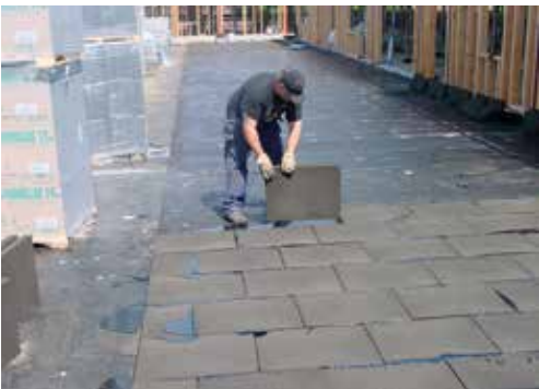
Montage av FOAMGLAS® BLOCK
