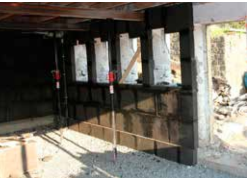
Invändig isolering av vägg med lim PC56.
