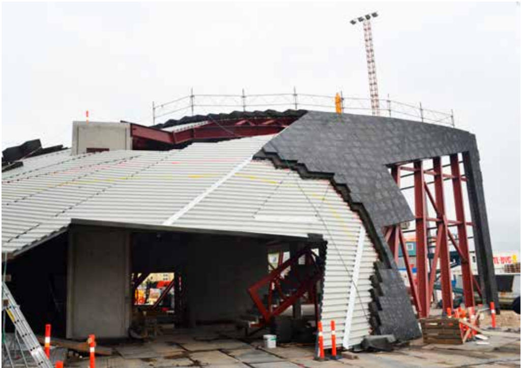
Isolering av fasad med plåtbeklädnad. Musikens hus Århus, Danmark
