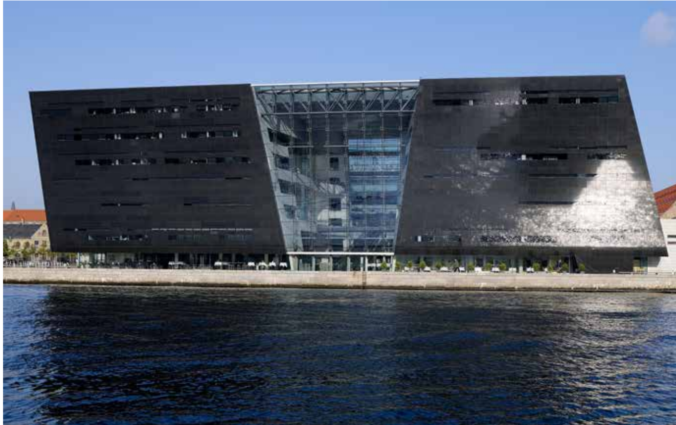
Isolering av tak – Kungliga biblioteket, Köpenhamn Danmark
