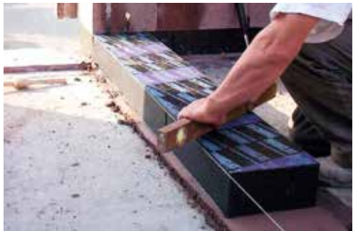
Isolerings-elementet kan kombineras med alla vanligt förekommande typer och storlekar av murblock och prefabricerade väggar.
