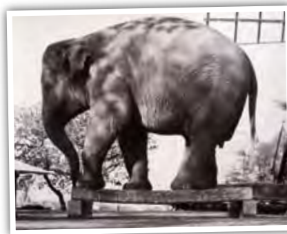
Träullit Takelement hållbarhetstest i Stockholm år 1965 med Skansen-elefanten Gobi (1950 kg).
