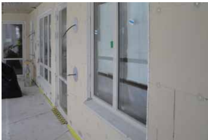
Bild ovan: PIR-isolering på flerfamiljshus i Kv Vålbehaget, Stockholm
