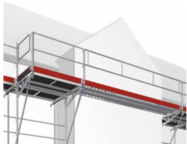
34 Utsprång, t. ex. burspråk eller balkonger, täcks på ett enkelt sätt in med motsvarande långa konsoler. Utkragningen täcks av plattformar med erforderlig längd mellan konsolerna.
