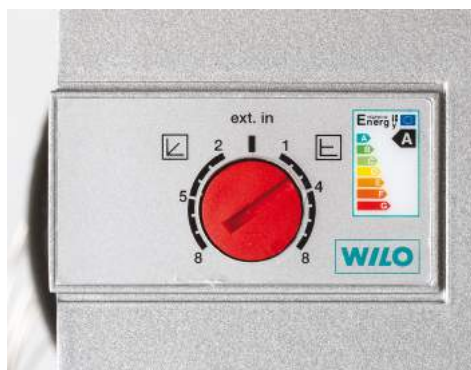
Bild: Justering av cirkulationspump
