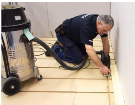
8. Spår för matning kan med fördel fräsas.
