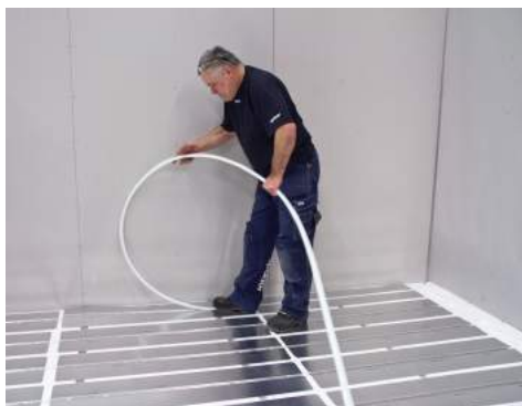
8. Montera röret i spårerna.
