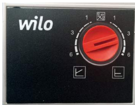
Bild: Justering av cirkulationspump
