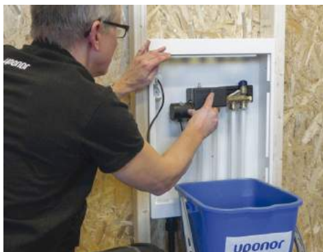
14. Montera isolersatsen för bästa energieffektivitet.
