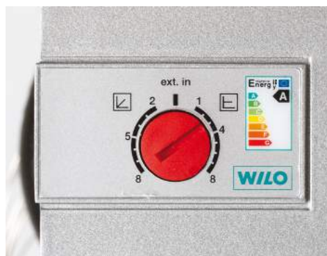
Bild: Justering av cirkulationspump
