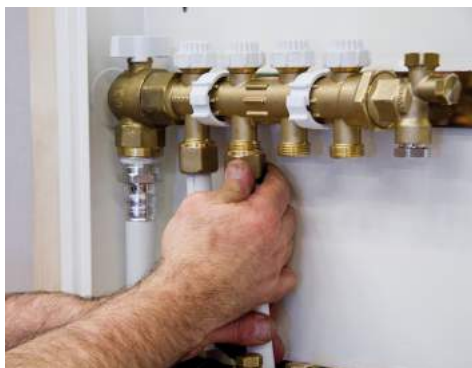
14. Skruva fast kopplingen i fördelaren.
