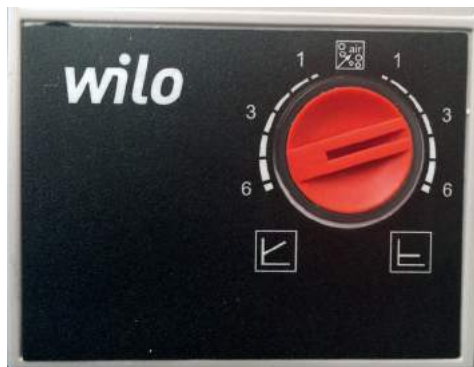
Bild: Justering av cirkulationspump
