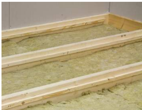
3. Bjälkar med monterad bärläkt.
