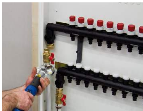
13. Montera matningsröret, i detta fall MLC-rör.
