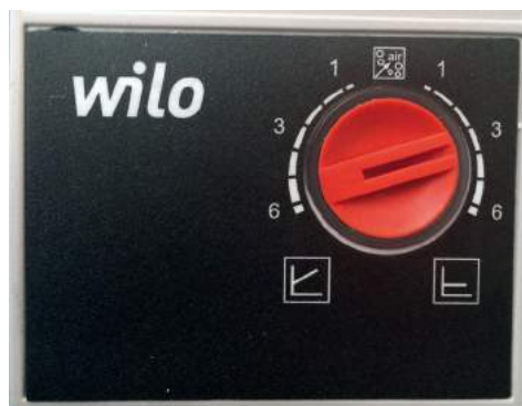
Bild: Justering av cirkulationspump
