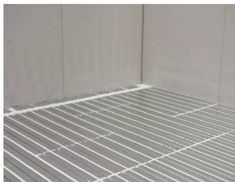
12. Installationen är klar.
