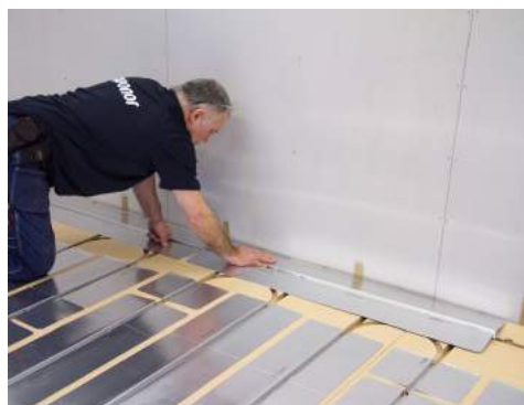
13. Montera plåtar även i matningsspåret.
