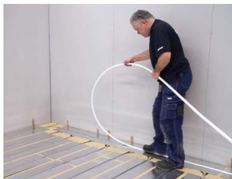
14. Montera golvvärmeröret.
