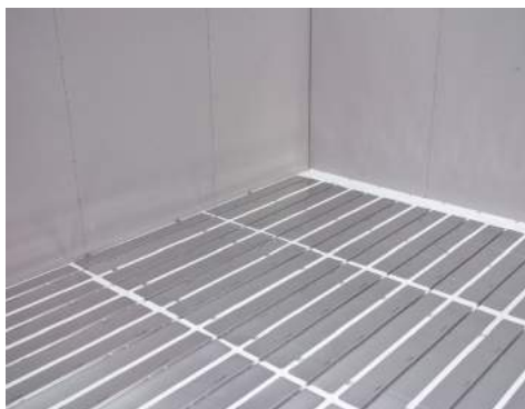
6. Lägg plåtarna med minst 10 och max 100 mm mellanrum. Plåtarna kan lätt delas vid knäckanvisningarna. Använd gärna överbli ven plåt från första spåret i nästa spår för att minimera spillet.
