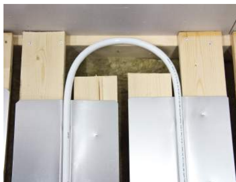
11. Exempel på korrekt vändning av röret.
