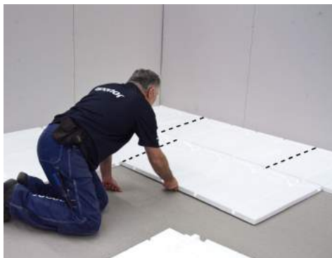
4. Lägg skivorna med förskjutna skarvar.
