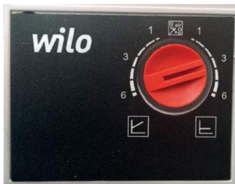
Bild: Justering av cirkulationspump
