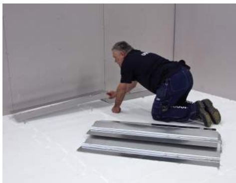
5. Montera värmeavgivningsplåtarna i golvvärmesnivåns spår.
