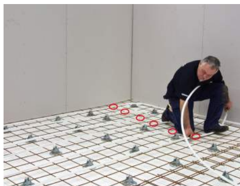
4. Fäst rören så att röret bara najas på varsin sida om vändningen.
