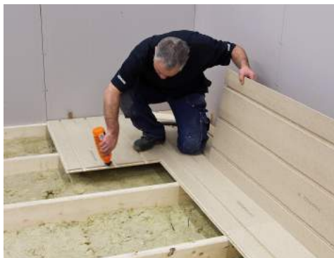
11. Var noga med att applicera tillräckligt med lim.
