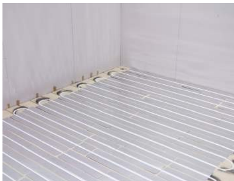
26. Installationen är klar.
