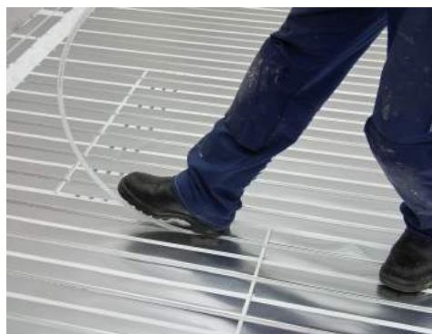
11. Rördragning i rakt spår.
