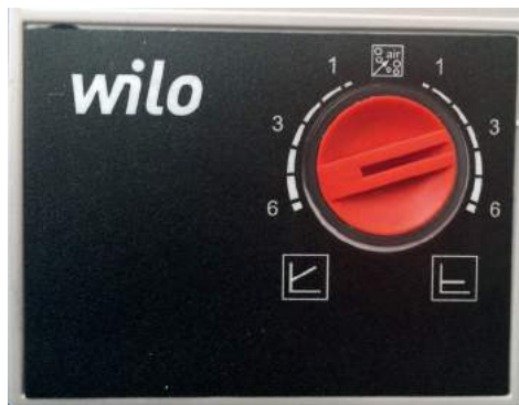
Bild: Justering av cirkulationspump
