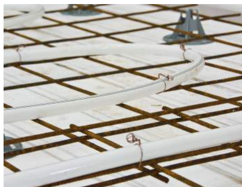
6. Max 750 mm mellan fästpunkter på rörets raka del och 200 mm i vändningarna.
