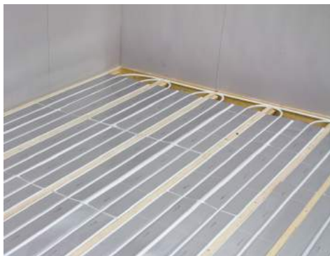
12. Installationen är klar.
