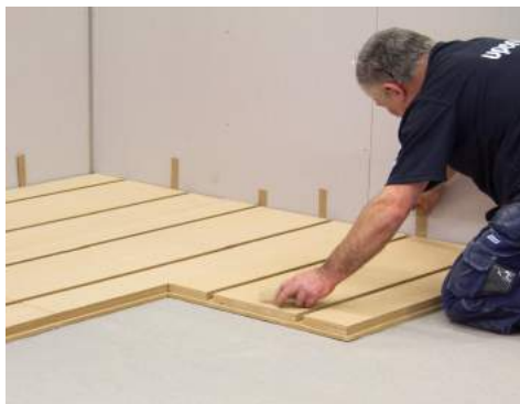
6. Lägg skivorna med förskjutna skarvar.
