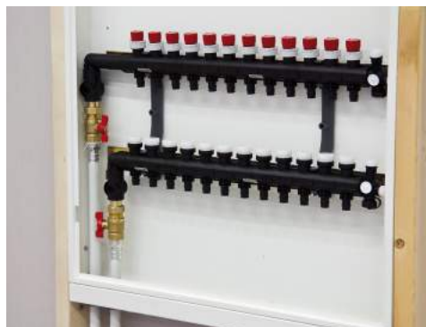
14. Installation av matningsrör klar.
