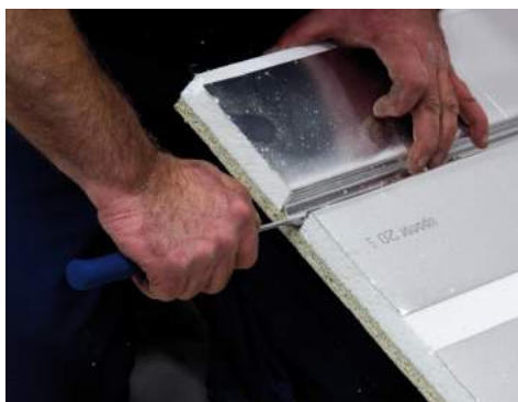
6. Avgrada plåtarna där röret ska ligga.
