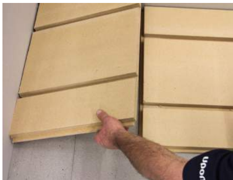
5. Kapa skivorna så att not och fjäder kan passas i varandra.
