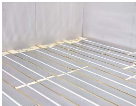
12. Installationen är klar.
