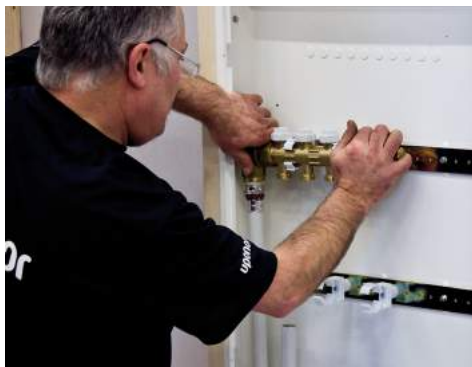
10. Tryck dit fördelaren i fördelarfästet – ganska stor kraft är nödvändig. Ett högt snäpp hörs när fördelaren är på plats.
