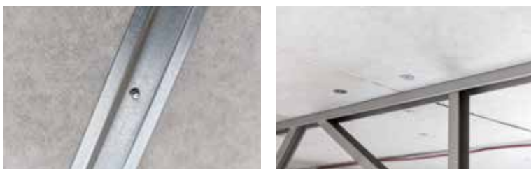
Montage med MT-profil kompletterat med bricka och skruv i centrum på varje skiva.
