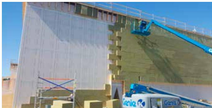
Arena i Knivsta, byggs i massivträ och isoleras enligt passivhusstandard med PAROC Klimatskiva ZERO. Beräknas stå helt klar 2020.
