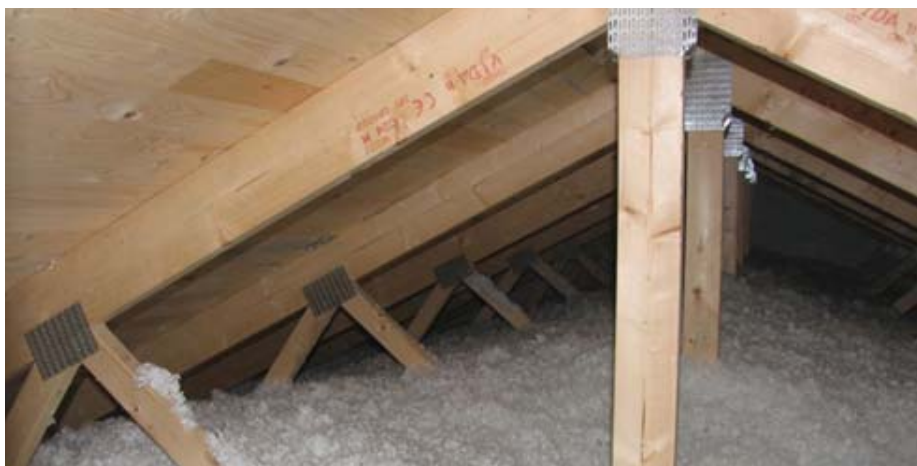
Kombinerad lösning med sluten takfot och vindsbjälklag i tak med saxade takstolar.
