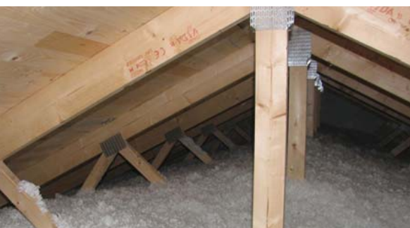
Kombinerad lösning med slutet takfot och vindsbjälklag i tak med saxade takstolar.
