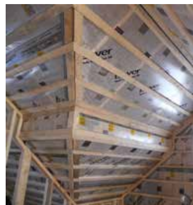
Lufttätning och ångbroms med ISOVER Vario Xtra.
