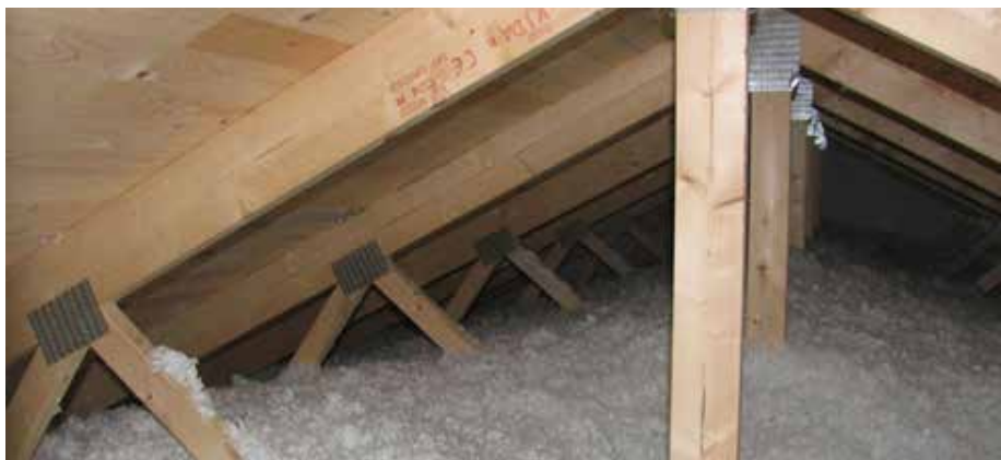
Kombinerad lösning med sluten takfot och vindsbjälklag i tak med saxade takstolar.
