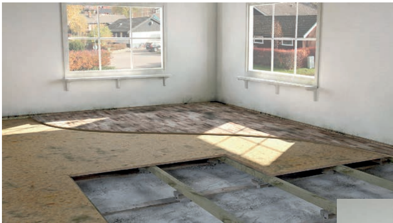
2. Betongplattan rengörs från allt organiskt material.
