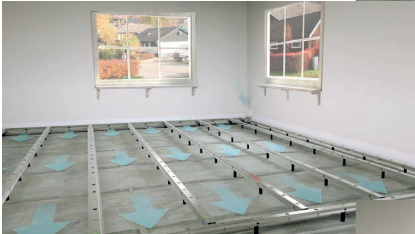
3. Granab Golvregelsystem med undergolvsventilation och isolering monteras.
