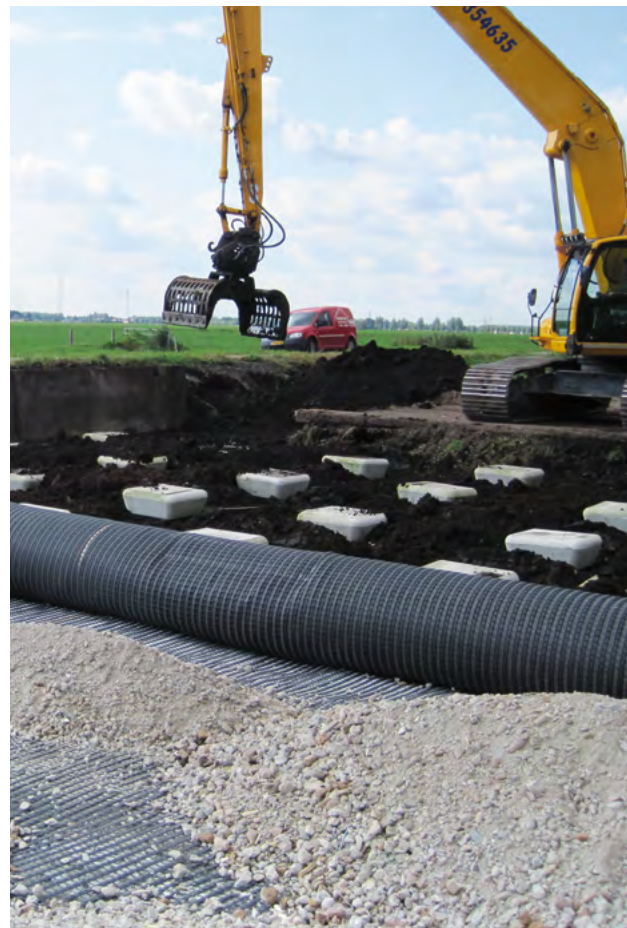
Pålförstärkning armerat med Fortrac Geonät (N 210; Netherlands)
