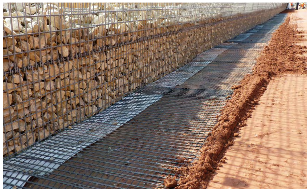
Bottenstabilisering av en gabionvägg (A3 motorväg nära Haseltal, Germany)
