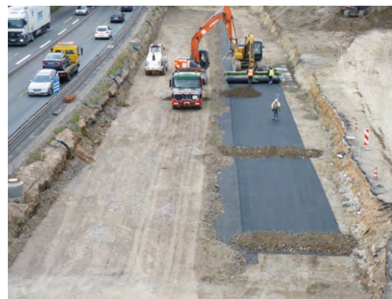
Reparation av jordspricka (Bochumer Westkreuz motorväg (A 52), Germany)
