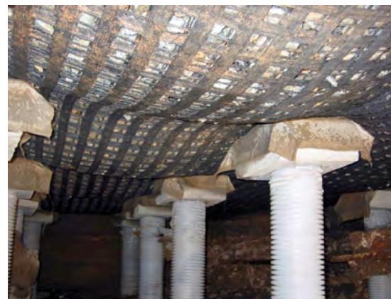
Membraneffekt vid pålförstärkning (Railway Bidor-Rawang, Malaysia)
