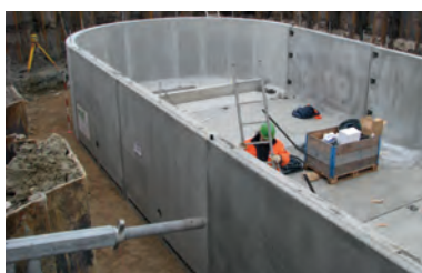
Runda/ovala förtillverkade tankar med U-profiler – Ø 5600 mm
