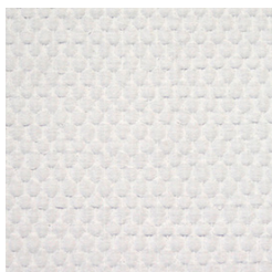
Närbild av ytskikt
