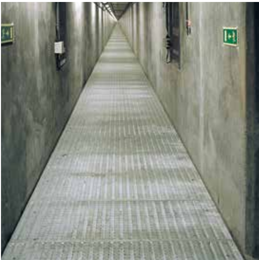
3 km lång utrymningsväg i Öresundstunneln.
