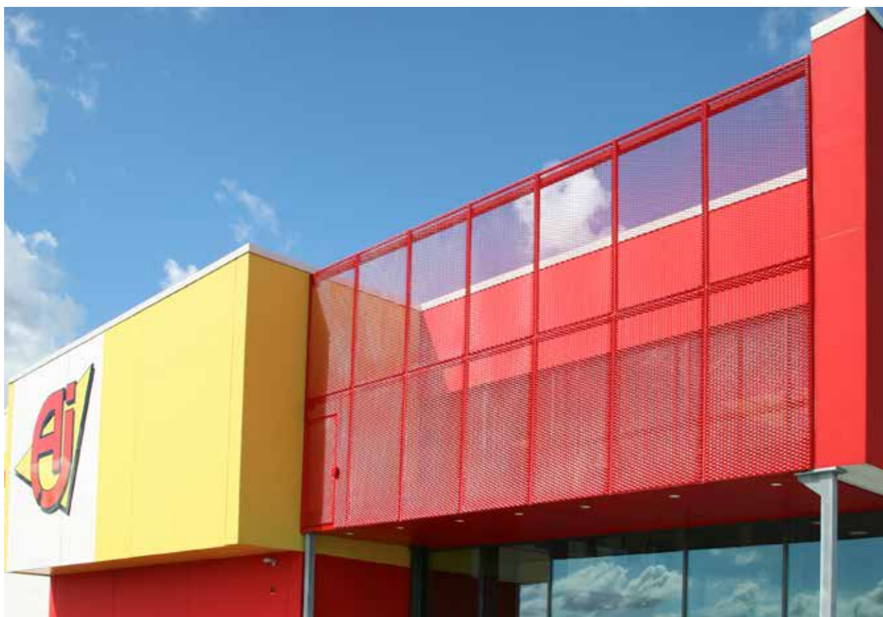
Flexmetall som dekor och skydd på utrymningsbalkong vid AJ Produkters anläggning i Halmstad. Flexmetall typ 8538/180-6020. Steglöst varierad stegbredd från 18 till 6 mm.
