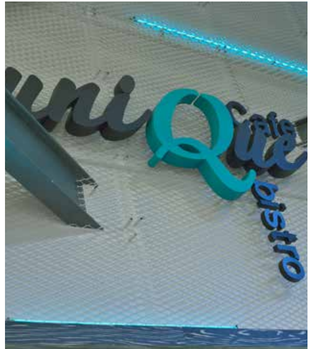
Belysning i företagets färger har placerats bakom flexmetallen som också fungerar som underrede till företagets logotype.
