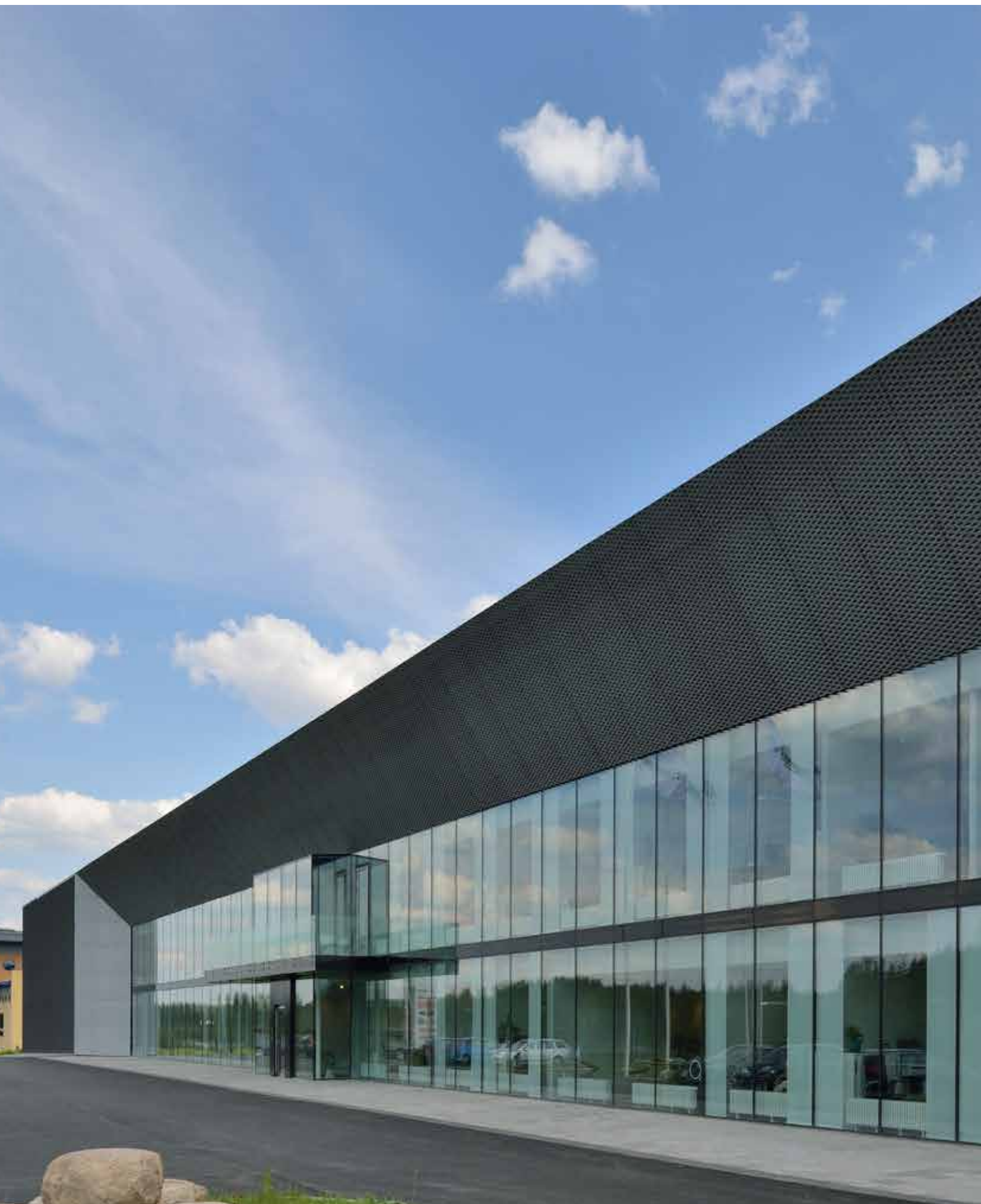
Fasad klädd med sträckmetall. VA-Teknik Sweden AB, Borås. Sträckmetall typ 20070/32020. Obehandlad Aluminium.
