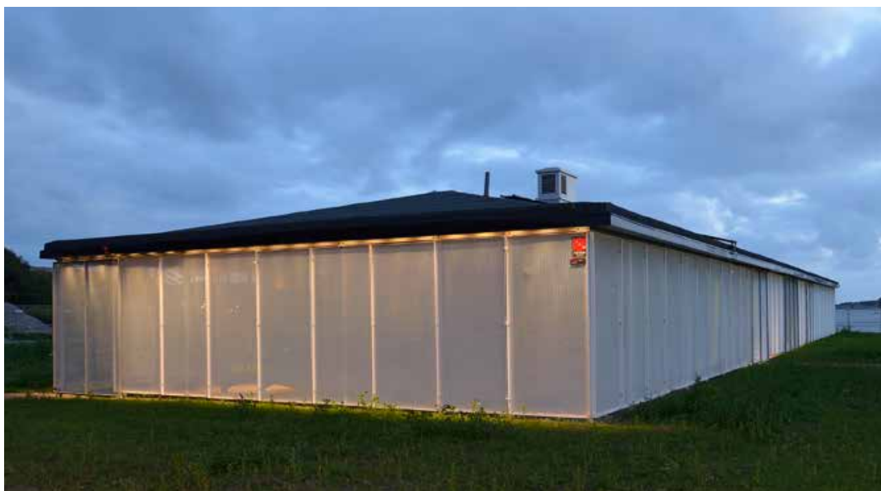
Sträckmetall runt omklädningsrum vid Askimsbadet, Hovås. Sträckmetall typ 4218/4030 plattvalsad och 6228/6030 plattvalsad. Varmförzinkat stål samt pulverlackering RAL 9010.
