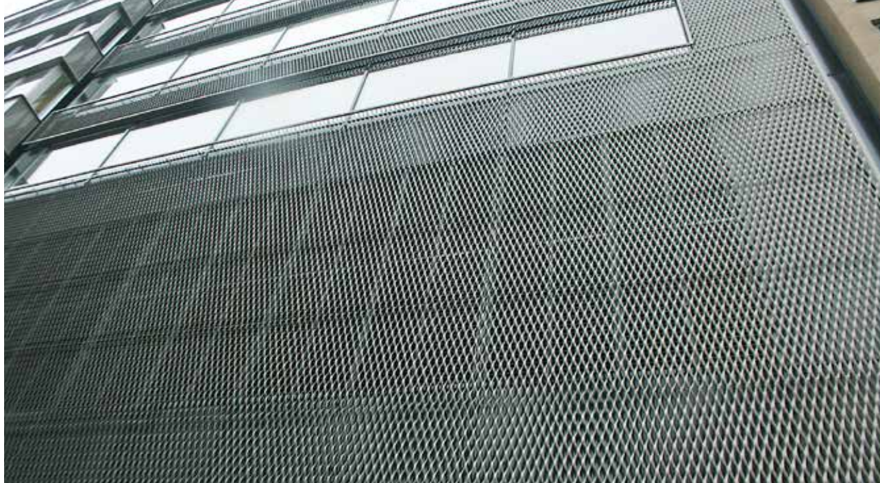
Sträckmetall på fasad vid Kv Bulten 19, Hornstull, Stockholm. Sträckmetall typ 20070/22030. Kopparanodiserad Aluminium.
