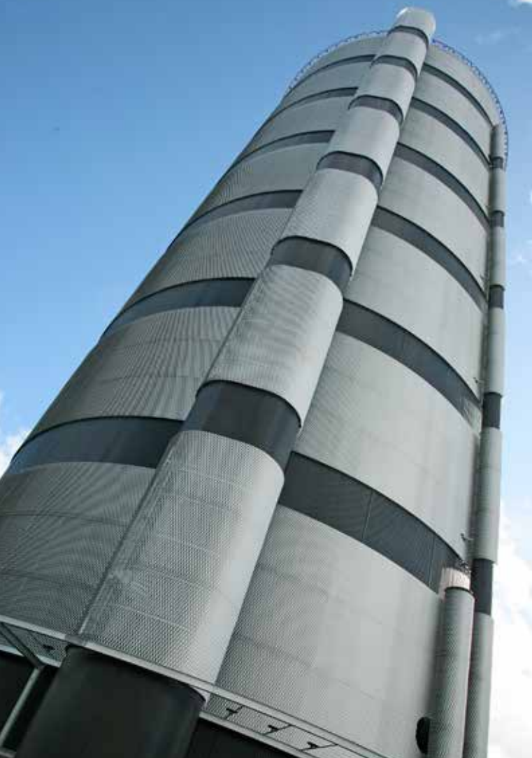
Sträckmetall på hetvattencistern Borås Energi. Sträckmetall typ 20080/33020 monterad med stående maska. Naturanodiserad Aluminium.
