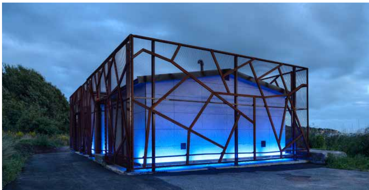
Sträckmetall i Cortén, Askimbadet, Hovås. Sträckmetall typ 4218/4030 plattvalsad och 6228/6030 plattvalsad. Corten.
