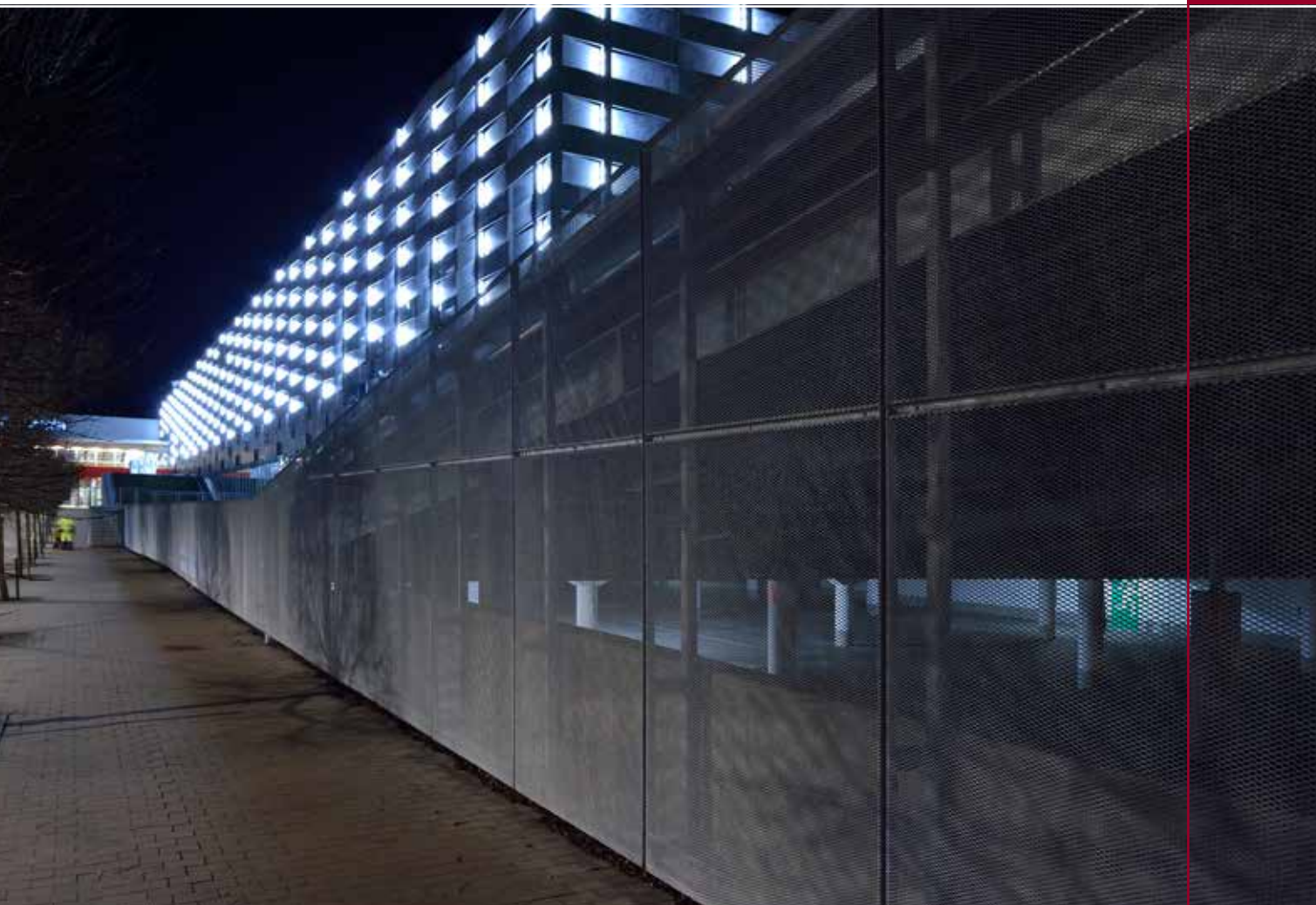
Sträckmetall vid parkeringshus Älvsjömassan. Sträckmetall typ 2812/4520. Varmförzinkat stål.
