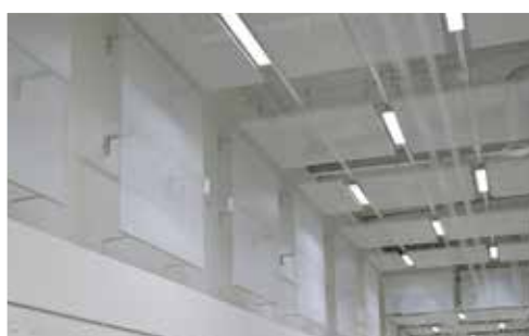
Vitlackerad sträckmetall vid entré Älvsjömassan. Sträckmetall typ 11544/25015. Pulverlackerat Aluminium.
