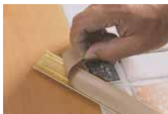
Montering med Elasticfix
